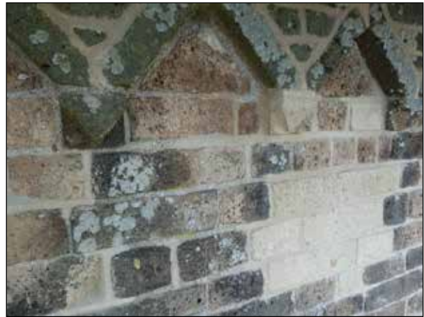
Figuur 9. Herstel aan de middeleeuwse toren te Drempt als voorbeeld van de wijze waarop in Nederland wordt omgegaan met middeleeuwse tufstenen torens. Vervanging van blokken is soms noodzakelijk omdat de tufsteen te zeer verweerd is. De oorspronkelijk gebruikte tufsteen (Römer tufsteen) is echter niet meer verkrijgbaar en wordt vervangen door Weiberner tufsteen, welke een iets andere kleur heeft en fijner van structuur is. Oorspronkelijk was deze tufsteen waarschijnlijk voorzien van een afwerklaag, waardoor de tufsteen mogelijk langer meegaat. Door dergelijke behandelingen zou het vervangen van materiaal, zoals hier getoond, mogelijk minder aan de orde zijn. Foto: H.J. Tolboom 2011.
