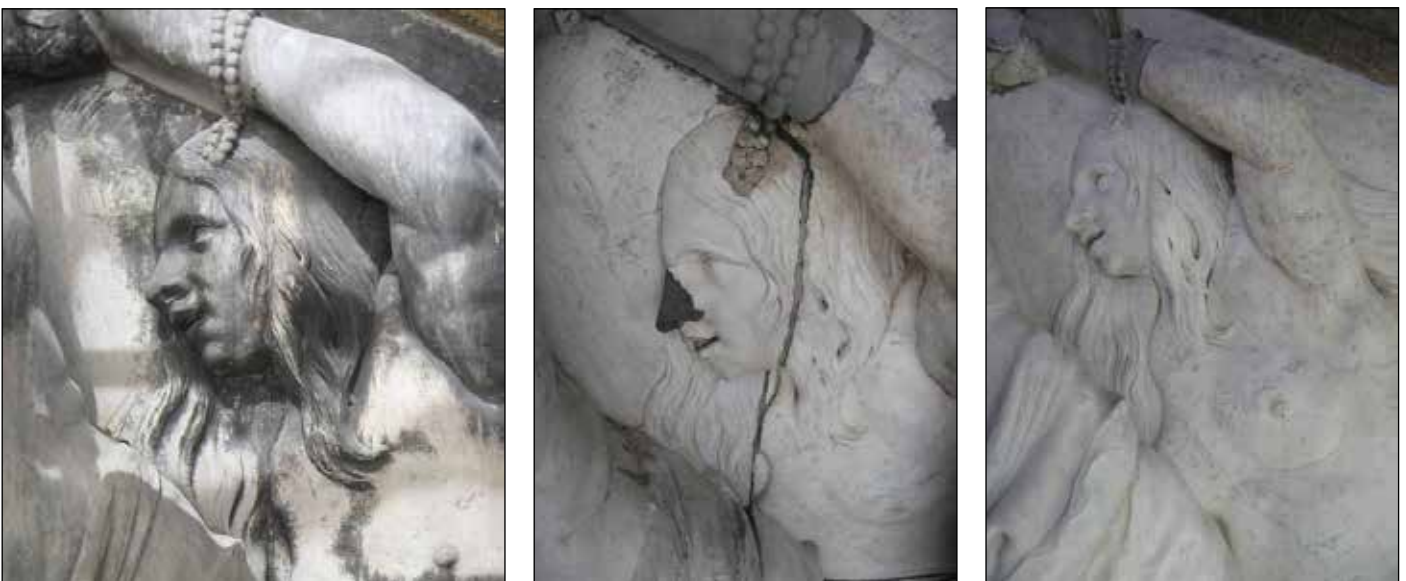
Figuur 4. Witmarmeren timpaan van het paleis op de Dam voor (links) en na (midden) reiniging door middel van droog stralen met aluminiumsilicaat onder lage druk. Hierdoor kwamen reparaties in het zicht die aangepast waren aan de vervuilde situatie. Met behulp van kleur is dit weer ontstoord (rechts). Foto: H.J. Tolboom 2010.
