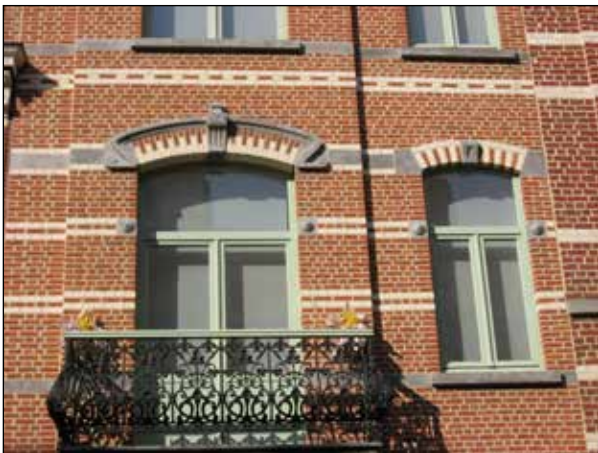
Figuur 44. Eclectische polychrome baksteenarchitectuur met Art nouveau-elementen aangeduid door verfijnde afwerking van Blauwe hardsteen. Frederik Lintstraat 121 (bouwperiode 1900-1914).
