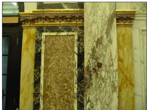
Figuur 10. Eén van de wanden van de marmeren hal bekleed met onder meer Portor, Giallo di Siena en Paonazzo. Foto Jan van 't Hof, 2013.
