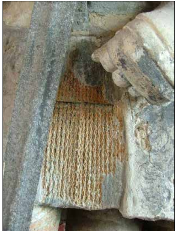
Figuur 6. Restanten van vergulding op één van de zeven beelden van Avendersteen, uit het begin van de 16 de eeuw, die tot ongeveer 1930 op de voorgevel van het Veerse stadhuis stonden. Foto: H.J. Tolboom 2010.
