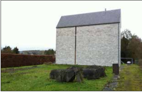
Figuur 4. Eigentijdse constructie, opgetrokken in het dorp Vodelée met kalksteen uit de plaatselijke groeve Hautmont (foto J. Delbroek).
