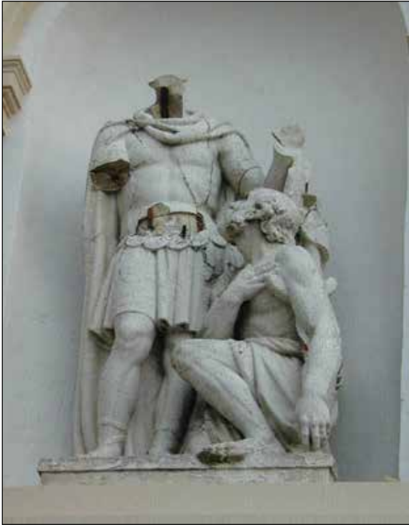
Figuur 7. Beeld van Avendersteen van de Antwerpse beeldhouwer J. de Cuyper uit 1851 aan de Sint-Martinuskerk te Westwoud. Het beeld stelt de heilige Martinus voor, die zijn mantel deelt met een man die het koud heeft. Door roestende doken en krammen is de steen gefragmenteerd; het verpakket is zeer dik en vertoont een grofmazig craquelé. Foto: H.J. Tolboom 2006.
