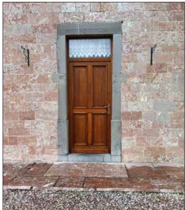
Figuur 3. Vernaculaire woningbouw met gebruik van lokale materialen: rode marmerachtige kalksteen in Vodelée uit de plaatselijke rode marmergroeve (foto J. Delbroek).
