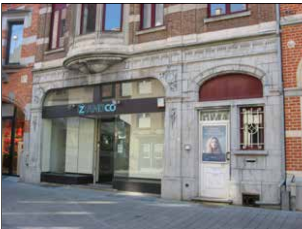
Figuur 42. Winkelpand met intact pui uitgevoerd in Blauwe Hardsteen met 'getand hoofdgestel: pilasterbegrenzing onder loofwerkmotieven voor de winkel en korfboogomlijsting voor de privé-ingang met flankerend getralied venster en bovenlicht' (Inventaris Onroerend Erfgoed ID72774). Arch. A. Devos, Wederopbouw met Art Deco elementen, 1922. Diestsestraat 76.
