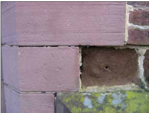
Figuur 8. Voorbeeld van het gebruik van Bontzandsteen bij de restauratie van het portaal van de Sint-Hubertuskerk te Schaffen.
