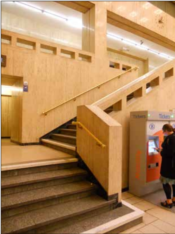
Figuur 36. Het Brusselse Centraal Station, ontworpen door de architecten Victor Horta en Maxime Brunfaut, 1937-1952. Eén van de trappen in de centrale hal. De vloeren zijn belegd met Larrys, de traptreden zijn van gneiss uit Ticino, de stootborden van Bleu Belge. Voor het paramentwerk zijn grote hoeveelheden travertijn gebruikt. Voor 1940 werd voor opgaand werk nog geregeld massief materiaal gebruikt maar hier is plaatmateriaal toegepast. Foto Jan van 't Hof, 2013.
