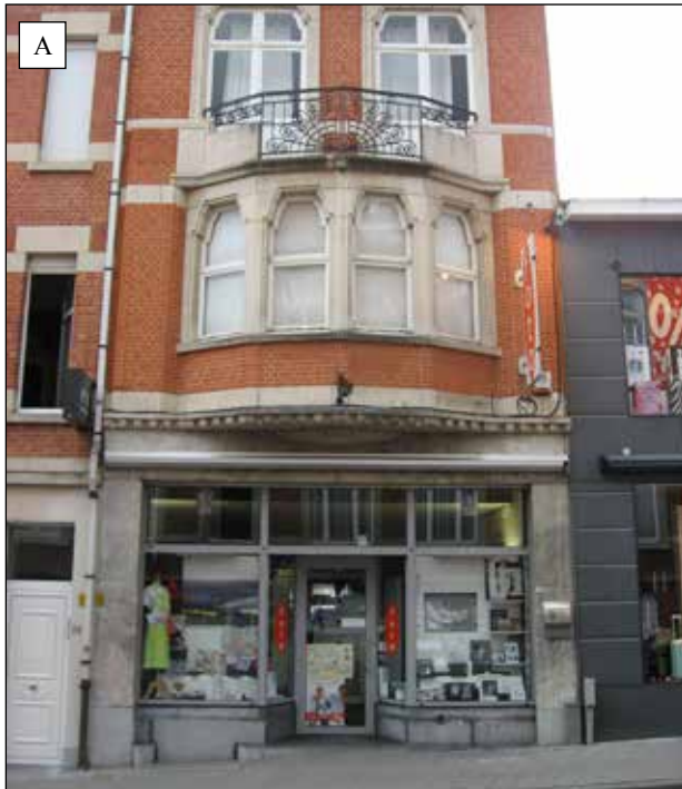
Figuur 9. A. Gerenoveerd winkelpui met restanten van oorspronkelijke marmerbekleding, Interbellumwoning met zware decoratie in Franse steen. Vital Decosterstraat 26.
