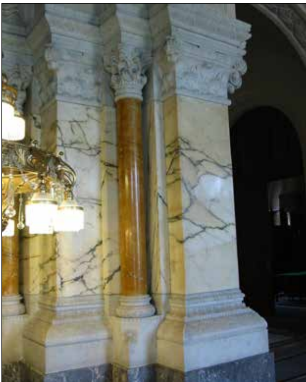
Figuur 12. Het Vredespaleis in Den Haag (1913). Pilasters van Paonazzo uit Carrara in de voorgalerij. De pilasters waren een geschenk van de Italiaanse regering aan de oprichter van het gebouw, de Carnegie-stichting. De pilasters en kapitelen werden geheel gereed uit Italië naar Den Haag gevoerd. Foto Jan van 't Hof, 2012.
