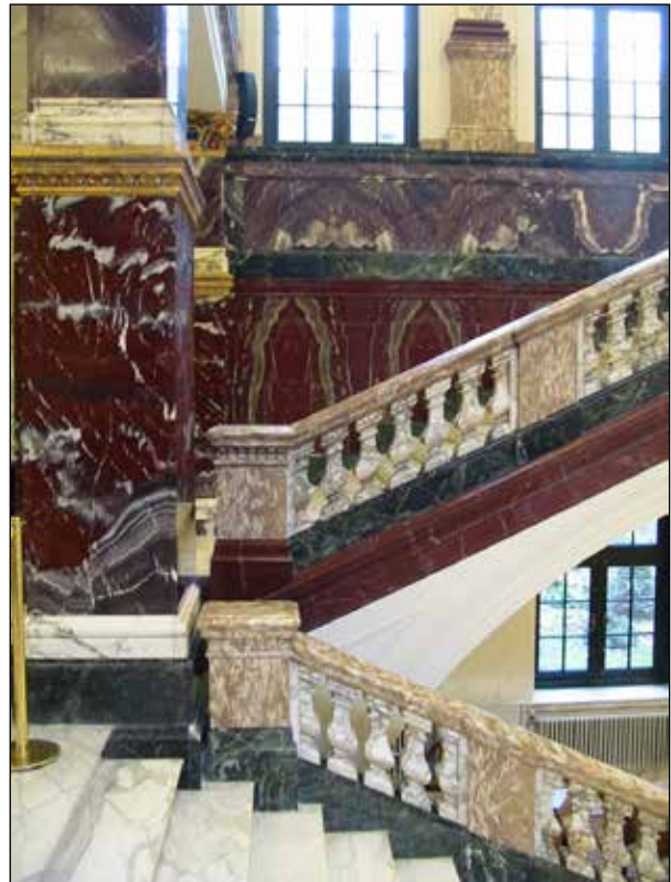
Figuur 9. De trap naast de marmeren hal van het Koninklijk Instituut voor de Tropen te Amsterdam (1926). Verschillende marmers, geplaatst op de wijze van open boek, imiteren een decoratie van slingers en tapijten. Foto Jan van 't Hof, 2013.
