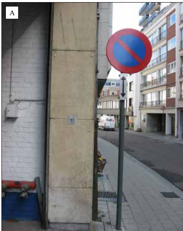
Figuur 22. Grootwarenhuis met gevel volledig uitgevoerd in Savonnières (bouwjaar 1960). De poreuze steen met kriskras gelaagdheid vangt vervuiling op. Bondgenotenlaan 70.
