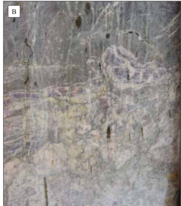
B. Italiaans marmer, violette breccie van Versilia, verbleekt door blootstelling aan de elementen. Vital Decosterstraat 26 (identificatie Florence Peltier, Musée du Marbre, Rance).
