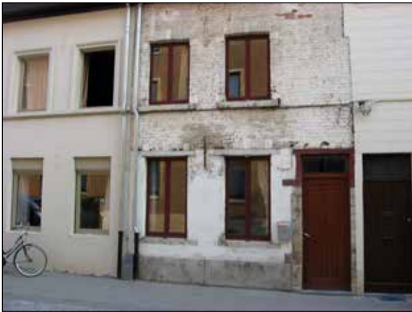
Figuur 26. Vroeg 19 de eeuwse vernaculaire woningbouw met behoud van de oorspronkelijke houten structuur boven de witstenen opstand langs de deur. De omgevende bepleisterde gevels zijn allicht laat 19 de eeuwse verbouwingen. Vlamingenstraat 6.
