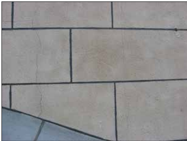
Figuur 11. Eclectisch herenhuis in similliteen in fijngebarsten geelwitte cementpleister met schijnvoegen, op een sokkel van blauwe hardsteen. Craenendonck 12.
