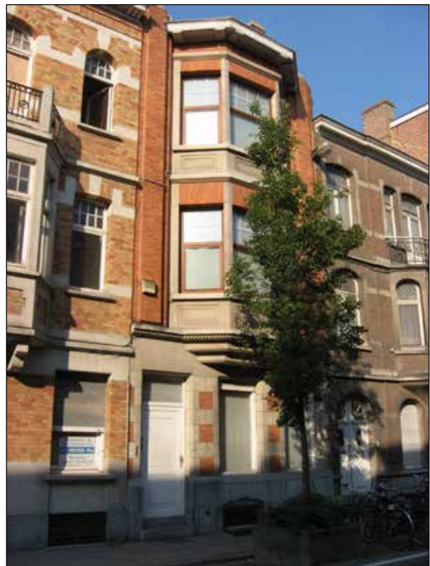
Figuur 31. Interbellumarchitectuur met Art Deco tendens, met uitgebreid gebruik van compact maar korrelig verwerende Franse steen, toegewezen aan Massangis. Arch. C. Koekelkoren, Dirk Boutslaan 23.
