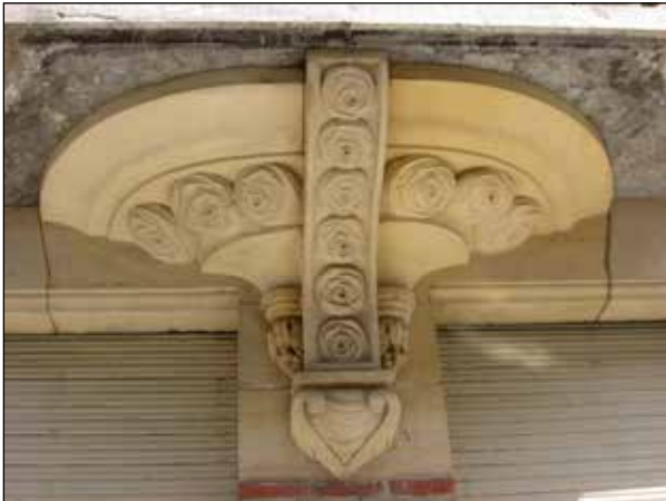
Figuur 15. Voortgezette eclectische bouwstijl van het vroege Interbellum: erkerconsole met florale motieven, uitgevoerd in Savonnières (imitatie-natuursteen volgens Inventaris Bouwkundig Erfgoed). Regastraat 32, arch. A. Mommaerts, 1922.
