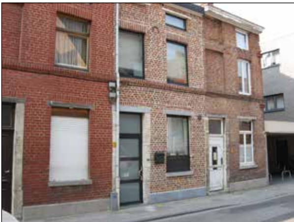
Figuur 38. Vernaculaire ‘burgerhuizen’ die van hun aanleg omstreeks 1840 de Gobertange deurstijlen hebben bewaard en in diverse stadia van renovatie verkeren, maar waar de oorspronkelijke bouwstijl is gerespecteerd. Prelatenstraat 25-29.
