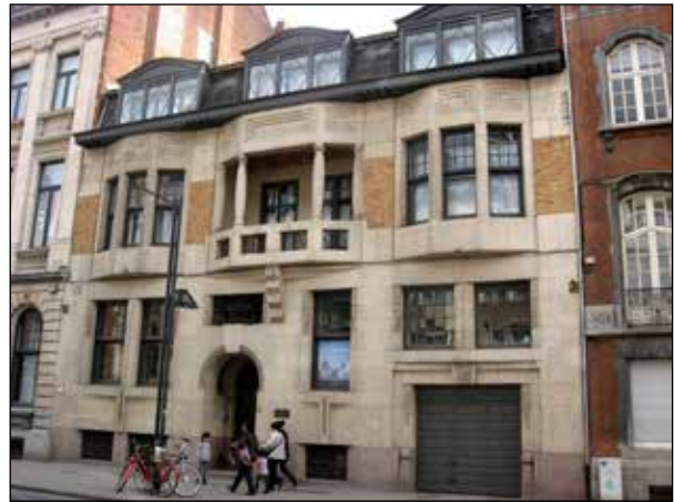
Figuur 36. Imposante gevel van herenhuis in zuivere Art Deco stijl, met sokkel in roze graniet (uitzonderlijk voor Leuven) onder Euvillesteen. Bondgenotenlaan 136, bouwjaar 1922.
