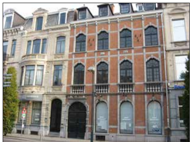
Figuur 14. Wederopbouw na Wereldoorlog I in eclectisch toegepaste uitgewerkte neostijlen. Herenhuys afgewerkt in blauwe hardsteen in opvallend lichte vormgeving naar Régencestijl (bouwjaar 1923). De omgevende huizen in Beaux Arts neostijl hebben volledige gevels in Franse steen (Savonnières). Bondgenotenlaan 111.
