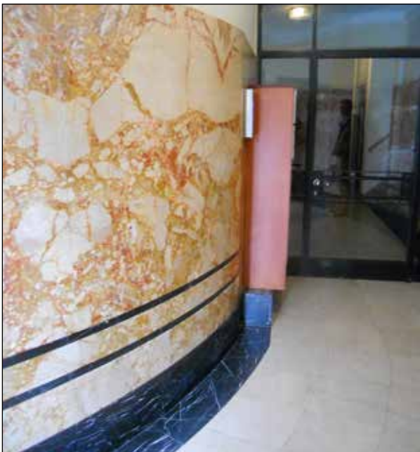
Figuur 24. De entree van Aarlenstraat 78 bezit een ongeïdentificeerde breccië geplaatst als open boek, nota bene tegen een gebogen wand. Foto Jan van 't Hof, 2013.
