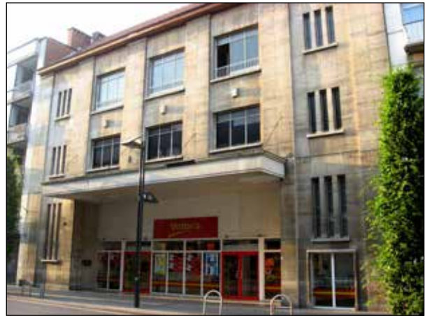
Figuur 22. Grootwarenhuis met gevel volledig uitgevoerd in Savonnières (bouwjaar 1960). De poreuze steen met kriskras gelaagdheid vangt vervuiling op. Bondgenotenlaan 70.
