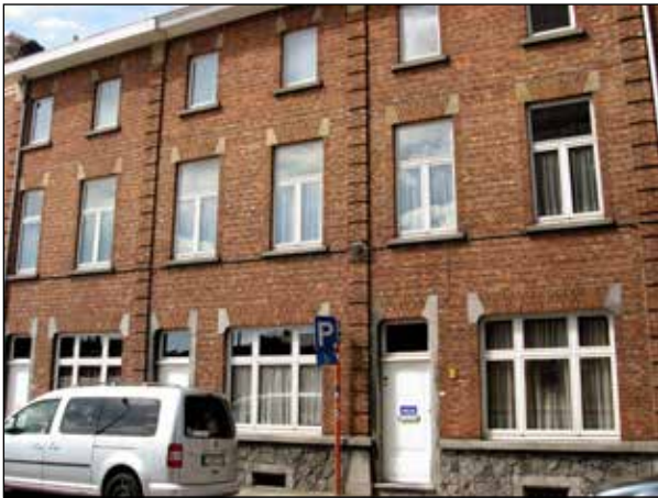
Figuur 29. Vroege interbellum baksteenarchitectuur met natuursteenvoorkomen in normale orde: plint in Blauwe Hardsteen in wild verband, ingebed in grijze gladgeschaafde Blauwe Hardsteen lijsten en hoekstenen op gelijkvloers, voortgezet door gele Savonnières op de verdiepingen. Brabançonnestraat 94-90.
