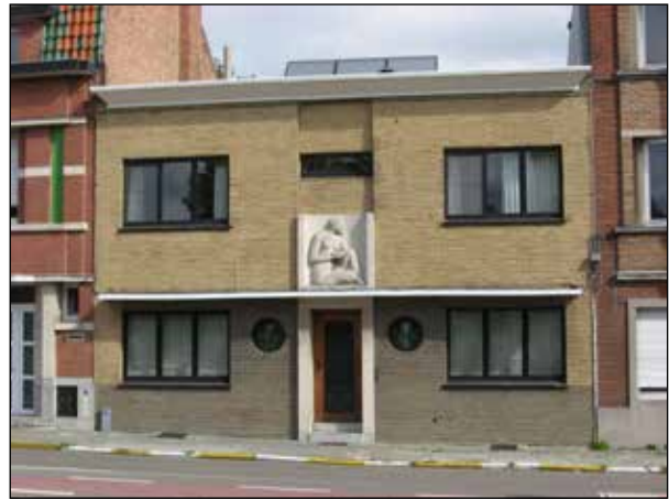
Figuur 30. Modernistische woning met betonskelet, natuursteen beperkt tot Euville aangewend voor een vlakke maar opvallende sculptuur. Arch. P. Stevens, 1935. Redingenstraat 114.
