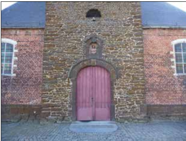
Figuur 4. Vroeg-romaanse Sint-Catharinakerk in Kortrijk-Dutsel, waarvan de toren volledig in ijzerschollen uit de onmiddellijke omgeving is opgetrokken.
