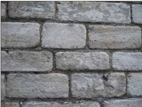
Figuur 1. Parementblokken bij het raadhuis te Schoonhoven. De blokken zijn bij de restauratie, eind jaren twintig van de vorige eeuw, opnieuw bekapt met een tandijzer. Foto: H.J. Tolboom 2009.
