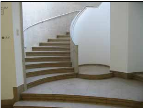
Figuur 22. Rotterdam, Museum Boijmans Van Beuningen; architect Van der Steur, 1936. Trap uitgevoerd in Comblanchien, paramentwerk van Bianco del Mare. Relatief nieuw was het grootschalige gebruik van travertijn. Foto Jan van 't Hof, 2011.
