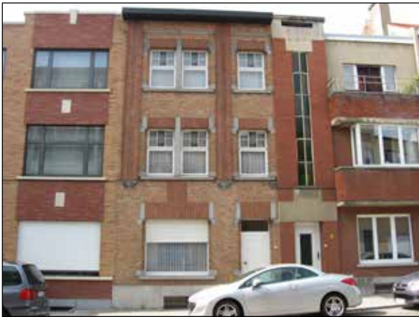
Figuur 17. Polychrome baksteenarchitectuur van het late Interbellum met toepassing van Blauwe Hardsteen als stopteken van de baksteendecoratie, omgeving door woning met baksteenpolychromie zonder natuursteen (bouwjaar 1935, links) en modernistische woning met beton en sierpleister (bouwjaar 1936, rechts). Constantin Meunierstraat 76 (bouwjaar 1935).
