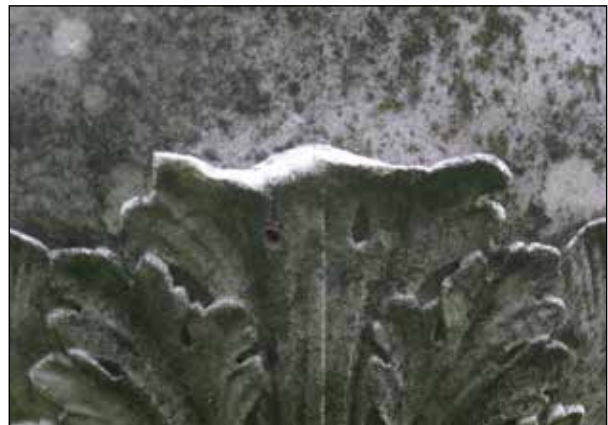
Figuur 22. Detail van een lange siervaas van wit marmer. Het materiaalverlies treedt vooral op aan de bovenzijde van de bladranden.
