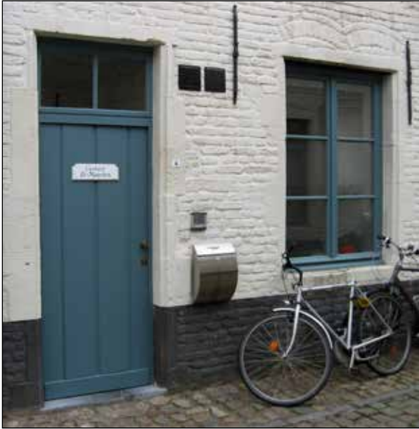
Figuur 1. Witsteen detaillering blijft goed zichtbaar onder kaleilaag en laat eenduidige interpretatie als Gobertangesteentoe. Klein Begijnhof 4, 17 de eeuws.
