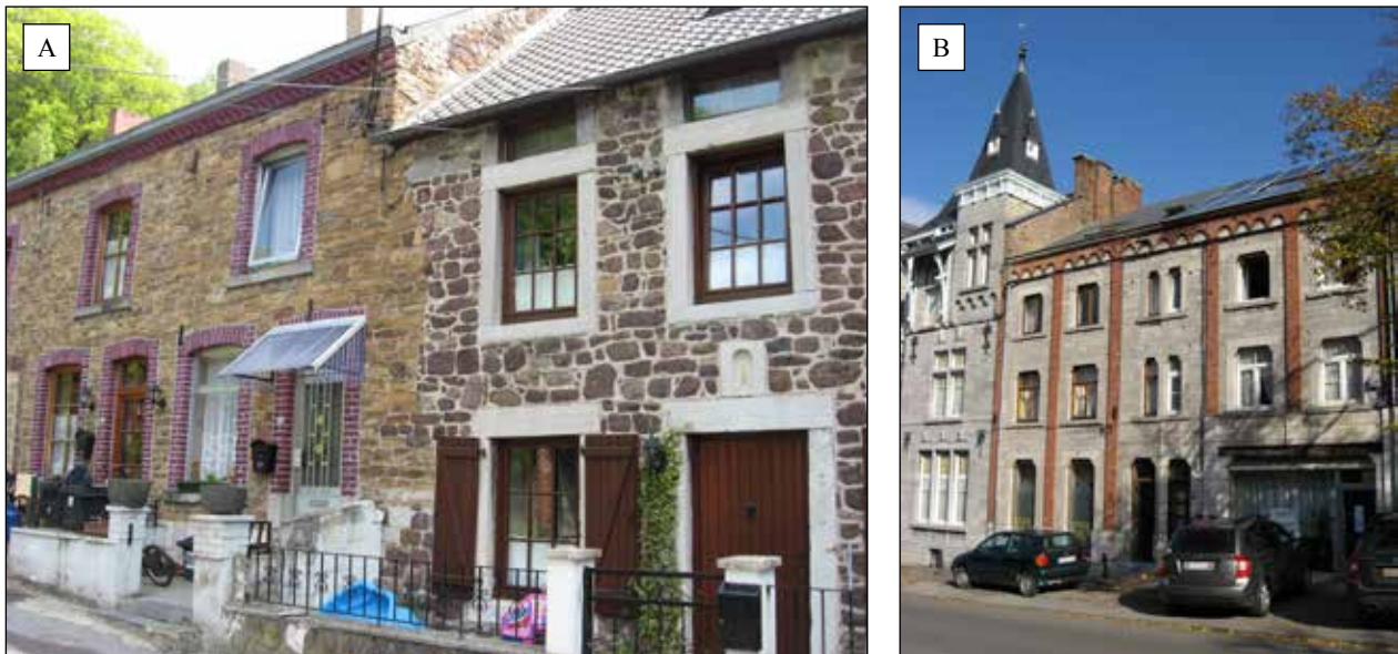
Figuur 1. A. Traditionele woningbouw met gebruik van lokale materialen (pierre d'avoine links, en Burnot conglomeraat rechts in beeld) illustreren de innige band tussen gebouw en landschap en de materiaaldiversiteit die er het gevolg van is; Rue Grand Péri, Vierset-Barse, in de Condroz (foto M. Dusar). B. Eclectische burgerhuizen in een kleinsteedse omgeving, opgestrooken in de lokale Devoonkalksteen. Rue de Behogne, Rochefort (foto M. Dusar).
