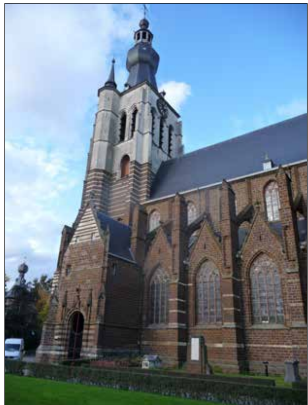
Figuur 5. Een zeer kenmerkend voorbeeld van de lokale architectuur in de Demerstreek is de Onze-Lieve-Vrouwekerk te Aarschot. IJzerzandsteen werd hier in het gevelparement gebruikt in combinatie met witstenen speklagen in Gobertangesteent.
