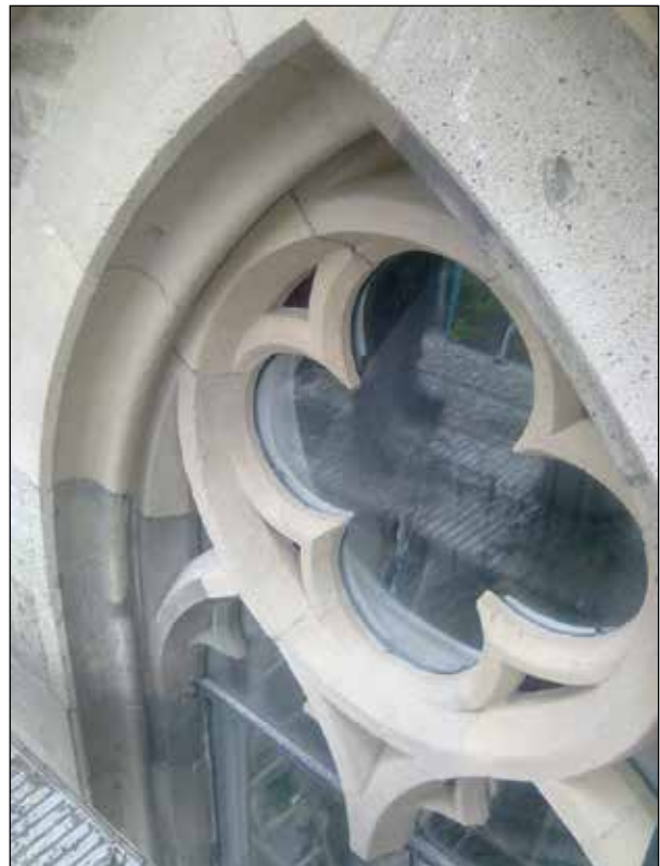
Figuur 10. Tufstenen venster van de Xantener Dom. Het bovenste deel van de tracering en een neggeblok (links boven het midden van de foto) behandeld met een kalkverf. Foto: H.J. Tolboom 2010.
