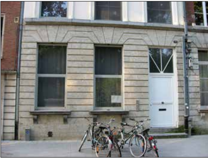
Figuur 39. Gelijkvloerse neoclassicistische gevel volledig in Gobertangesteent met dunne voeg, met diep ingekepte schijnvoegen die Franse steen moeten suggereren. Vlamingenstraat 45.
