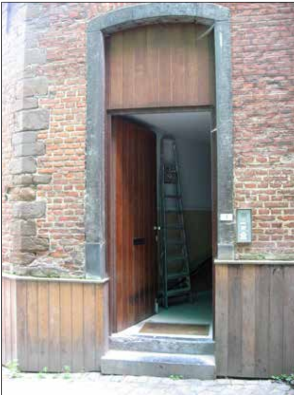
Figuur 24. Ottenburgse ijzerzandsteen-hoekketting verwijzend naar middeleeuwse bouwfase en slecht aangepast aan bestaande bebouwing. Rattemanspoort 4.
