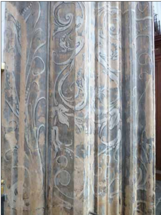
Figuur 3. Het inwendige van het schip van de Antwerpse O.L.V. Kathedraal werd in de jaren '70 van de vorige eeuw nog ontpleisterd. Het koor is deze behandeling gelukkig bespaard gebleven, waardoor nog een rijk archief aan afwerkklagen aanwezig is. Op de foto is de afwerking van de Sint-Jozefkapel te zien, daterend van omstreeks 1600. Foto: H.J. Tolboom 2013.
