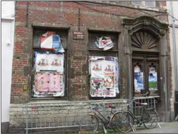
Figuur 12. Kunstig bewerkt hardstenen portaal in barokke gevel die verder met (oppervlakkig vervuilde) Ledesteen op mogelijk jongere plint van Gobertangesteen is afgewerkt. Parijstraat 38.
