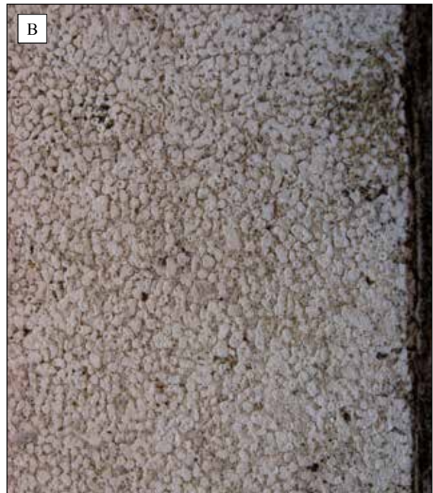
B. Kunststeen-imitatie van Euvillesteen, opgebouwd uit vermalen kalkbolletjes in gelige kalkcementmatrix. Burgemeesterstraat 18.
