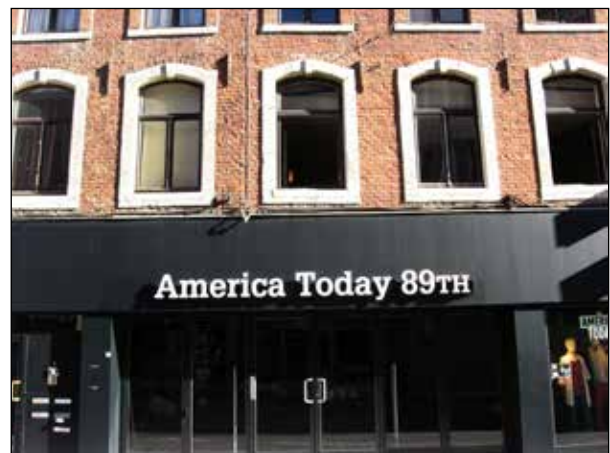
Figuur 40. Winkelpand met geheel vernietigd gelijkvloers, gevestigd in breedhuis uit de 2 de helft van de 18 de eeuw (rechterkant nr 91 ontleend volgens archief KIK), gekenmerkt op de verdieping door 'steekboogvensters in een zandstenen bandomlijsting met geprofileerde dagkanten en trapezoidale sluitsteen' (Inventaris Onroerend Erfgoed ID72780) in Gobertangesteent, in dubbele rij geplaatst als dorpel. Diestsestraat 89-91.
