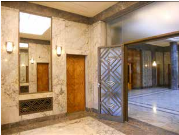
Figuur 26. De inkom en de centrale hal van de villa Empain zijn grotendeels met Escalettes en Bois Jourdan bekleed en ademen een ingetogen grootsheid; materialisatie en detaillering zijn met elkaar in evenwicht. Elders in het gebouw wint decoratie het van decorum door de toepassing van scagliola. Architect Michel Polak, 1930-1934. Foto Jan van 't Hof, 2013.
