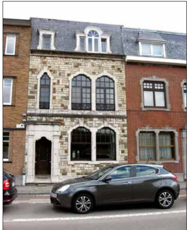
Figuur 19. Traditionalistische gevel opgebouwd uit enkel Belgische natuurstenen: Gobertangesteen voor de omlijstingen en de plint, Ledesteen, Kunrader kalksteen, Famenniaanzandsteen, Waismes arkose, Emsiaankwartsiet en roze zandsteen van Andenne als breukstenen. Tervuursevest 170 (bouwjaar 1937).
