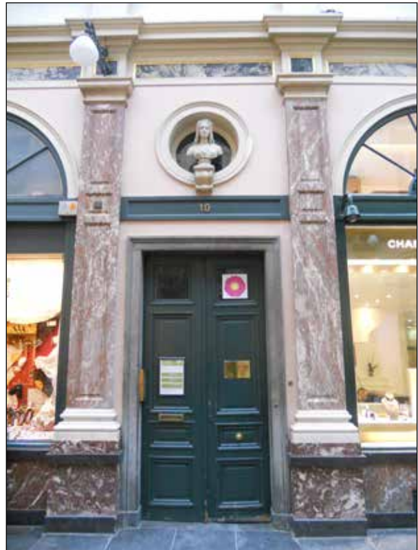
Figuur 2. Een fragment van de Koninklijke Sint-Hubertusgalerijen, opgeleverd in 1846 naar ontwerp van de Nederlandse architect Jean Pierre Cluysenaar. De vloer is belegd met hardsteen, de plint en de pilasters zijn bekleed met griotte, hardsteen, Carrara en rouge royal. Het fries onder de lijst is voorzien van een geschilderde evocatie van africano. Foto links Jan van 't Hof, 2013.
