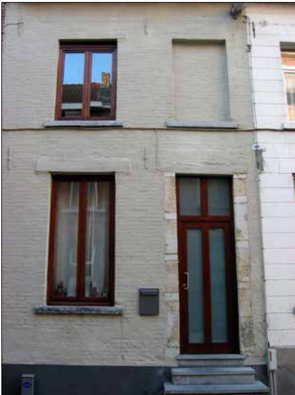
Figuur 27. Gerestaureerde vroeg 19 de eeuwse arbeiderswoning (ca 1840) met behoud van de houten latei. Ravenstraat 32.
