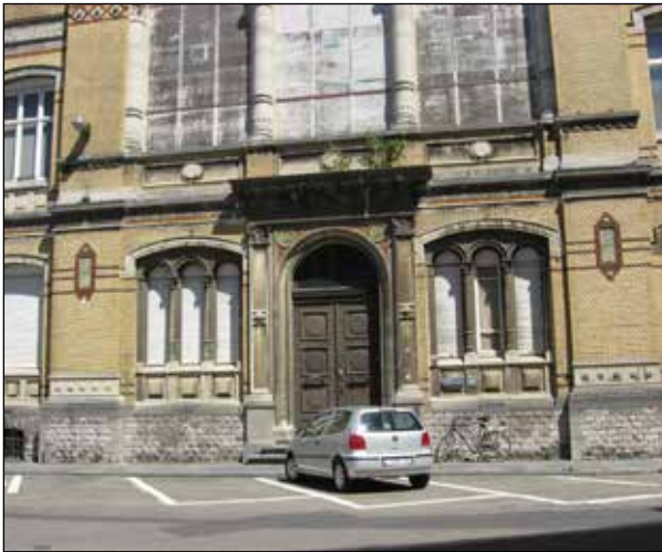
Figuur 32. Sokkel in ‘Grès rose de Java’, een Namuriaanzandsteen uit Andenne, gegeerd bij Art nouveau architecten. Arch. A. Van Arenbergh, 1897, eclectisch Instituut voor Bacteriologie, Vital Decosterstraat 102.
