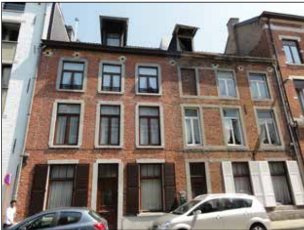
Figuur 13. Sobere vroeg-neoclassicistische gevelopbouw (ca 1800, meestal bepleisterd) met hardstenen lijsten. Geheel van voormalige pakhuizen, Wagenweg 13-15.
