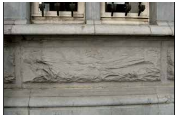
Figuur 3. Doornikse steen, grijze kleihoudende kalksteen in grote grof gebosseerde stenen met randslag. Voormalig Postgebouw in Vlaamse neorenaissancestijl, arch. A. Van Houcke, 1893.
