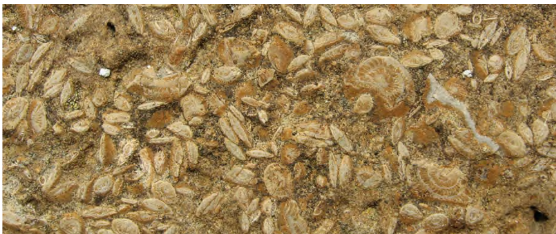
Figuur 4. Kops geplaatste Ieperiaanse steen zodat de nummulieten in bovenaanzicht zeer mooi zichtbaar zijn, Sint-Apolloniakerk Elst.
