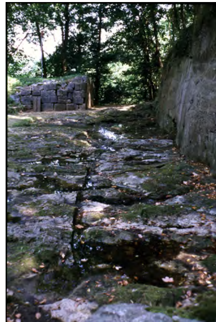
Figuur 10. Spoor van een smalle sleuf voor de ontginning van steenblokken op de bodem van de gracht van de burcht van Château-Thierry (Dinant) (Foto F. Doperé).
