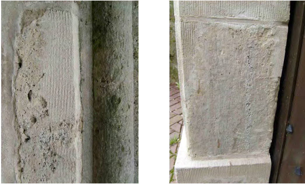
Figuur 8 en 9. Reparatie met herstmortel aan de Sint-Annakerk te Bottelare (Merelbeke)
