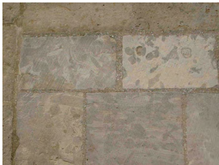
Figuur 6. Gobertange steen in de Sint-Ursmaruskerk te Baasrode (Dendermonde).
