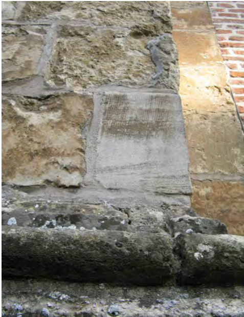
Foto 3 en 4 - Vervanging van de Ledesteen in de Sint-Annakerk te Bottelare door Euville (links) en Savonnière (rechts)
