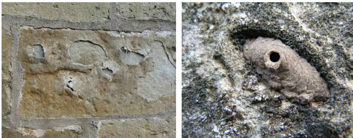
Figuur 6 en 7. Vorming van gipskorsten en gevolgen van gravende insecten in de Sint-Annakerk te Bottelare
