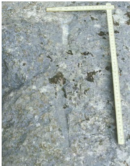
Figuur 7. Aanzet voor het uithouwen met een kleine zwaaispits (Fr.: mortaisoir) van een niet gerealiseerd groot spiegelat in de gracht van de burcht van Logne (Foto F. Doperé).
