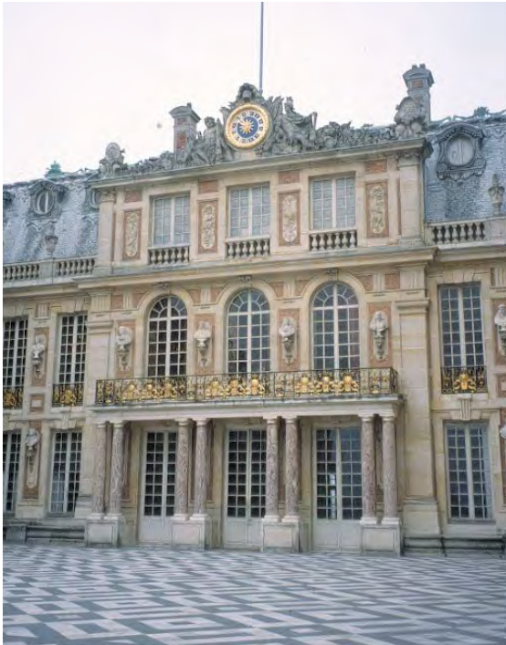
Figuur 19. Versailles – Cour des Marbres, gerestaureerd rond 1990 met Carrara marmer, zwart marmer van Doornik en blauwe hardsteen uit de groeven Gauthier-Winkz van Soignies. Zuilen van rood marmer van Rance geplaatst door LeVau om het kasteel van Lodewijk XIII (1631) te decoreren.
