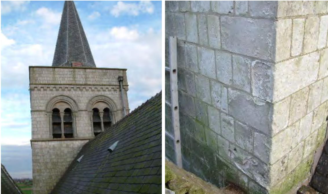
Figuur 2 en 3. Romaanse toren en detail parentment van de Sint-Mildredakerk te Izenberge. Avendersteen oorspronkelijk massief gebruikt voor de Romaanse klokkentoren. De toren werd in 1949 kort na de tweede wereldoorlog volledig afgebroken en met de oorspronkelijke stenen als buitenparentment tegen een binnenparentment in gele baksteen heropgebouwd. Deze Romaanse toren werd bij Koninklijk Besluit beschermd in 1938 en behoort tot de oudst gekende toepassingen van krijtsteen in de Zuidelijke Nederlanden. Foto's Jan Elsen.
