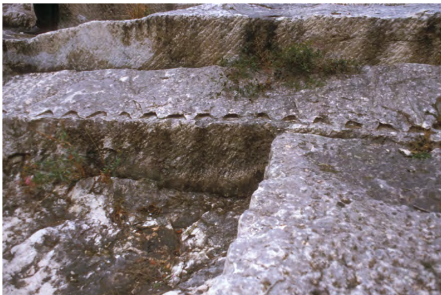
Figuur 3. Romeinse steengroeve Mathieu van Bois des Lens (Fr.) met een reeks horizontaal aangelegde trapeziumvormige spiegaten en de schuine lijnen op de verticale wanden veroorzaakt door het gebruik van een houweel (Fr.: escoude) bij het uithouwen van de kleine sleuven tussen de te ontginnen steenblokken (Opgraving J.-C. Bessac; foto F. Doperé).
