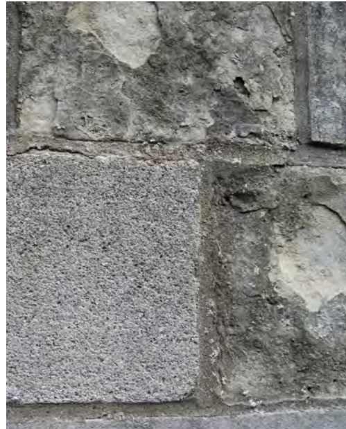
Foto 3 en 4 - Vervanging van de Ledesteen in de Sint-Annakerk te Bottelare door Euville (links) en Savonnière (rechts)
