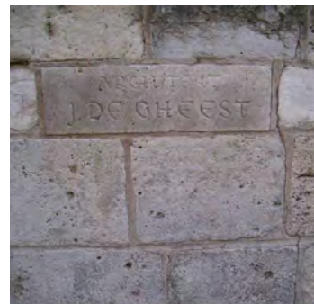
Foto 3 en 4 - Vervanging van de Ledesteen in de Sint-Annakerk te Bottelare door Euville (links) en Savonnière (rechts)
