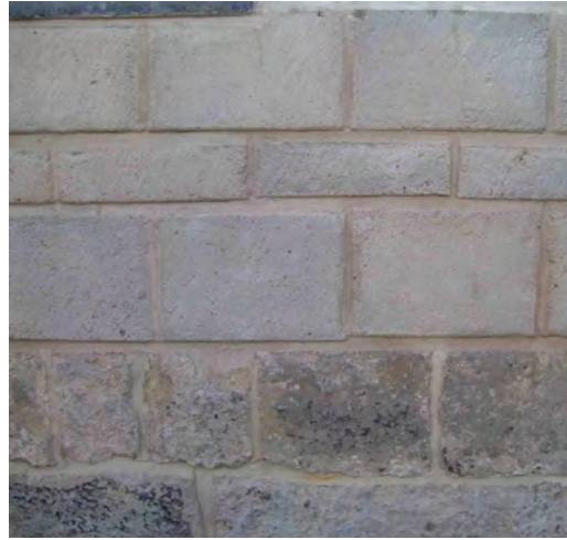
Foto 2 - Ledesteen vervangen door nieuwe Ledesteen (huis te Oordegem)
