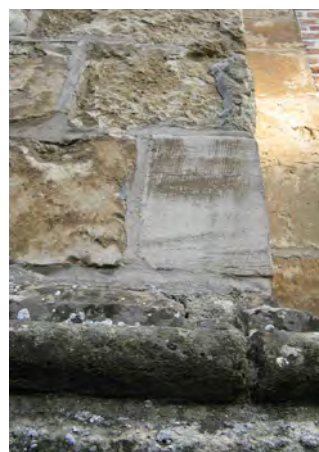
Ledesteen vervangen door respectievelijk Gobertangestein, Savonnière en Euville
