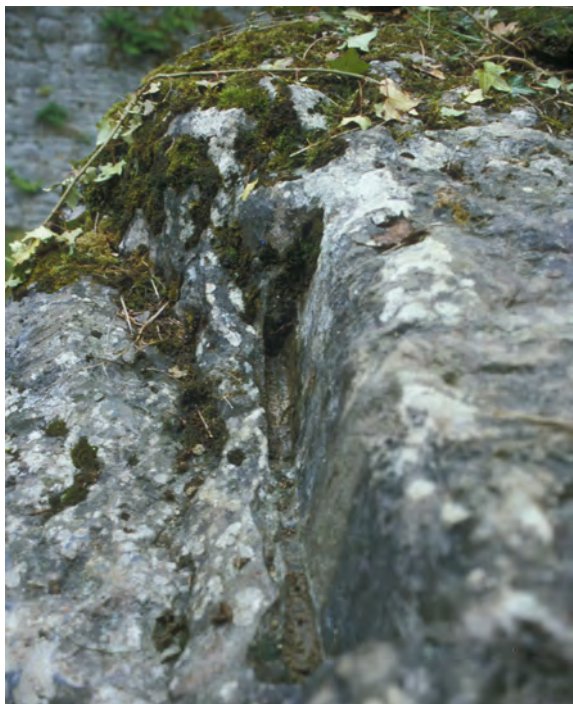
Figuur 6. Gehalveerd groot spiegelat met op de bodem twee parallelle sporen van 1 cm breed veroorzaakt door een kleine zwaaispits (Fr.: mortaisoir) aan de binnenzijde van de gracht van de burcht van Logne (Foto F. Doperé).
