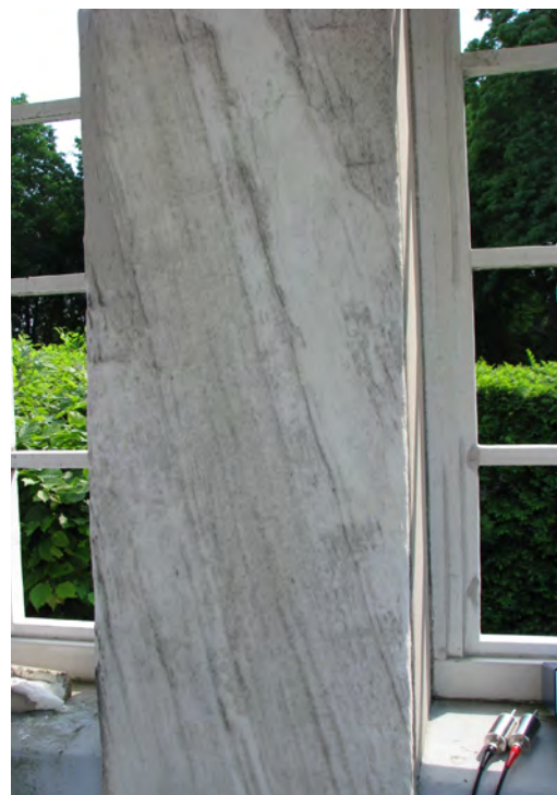
Figuur 2. Sterk versuikerd marmeren paneel. (Brussel, Stoclet Paleis)
