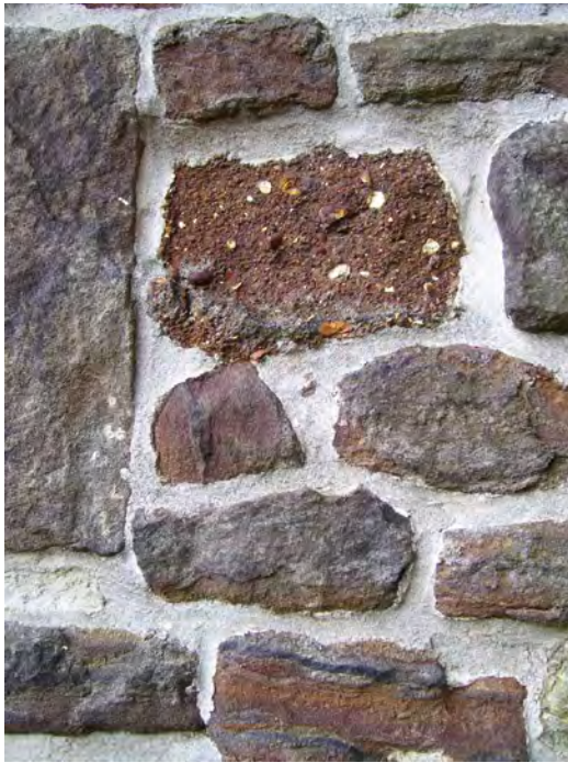
Figuur 1. Ijzervandsteen in de muur van de Sint-Apolloniakerk te Elst (Brakel).
