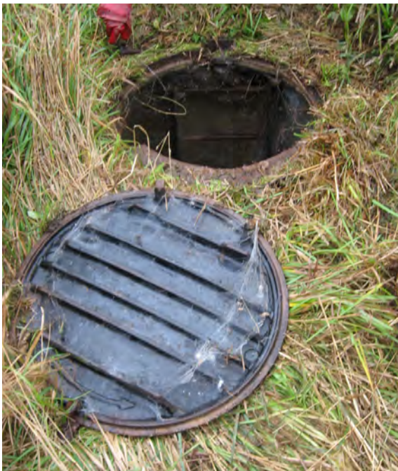
Figuur 8. Twaalf meter diepe toegangspuit tot de Fosse Leroy te Avesnes-le-Sec. (Foto Michiel Dusar)
