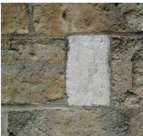
Ledesteen vervangen door respectievelijk Gobertangestein, Savonnière en Euville
