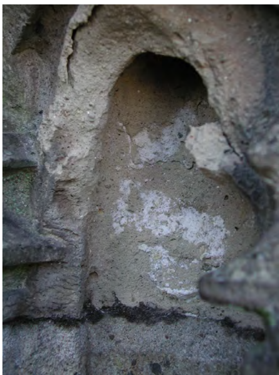
Figuur 1. Uitbloei van \text{Na}_2\text{SO}_4 op Weiberner tuf, St. Janskathedraal, 's-Hertogenbosch (okt. 2002).
