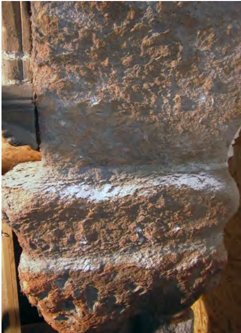
Figuur 7. Carboonzandsteen, verpoedering en afschilfering. (Tongeren, OLV Basiliek, Kloostergang)
