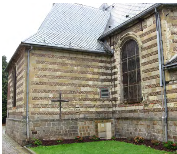
Figuur 17. Avendersteen in speklagen afgewisseld met 'trois rouges' (drie rijen baksteen voor een laag natuursteen) op een ondermuur van Oosterbant zandsteen (grès d'Ostrevent of Landenienzandsteen). St.-Gery kerk te Maing, grenzend aan Avesnes-le-Sec. Foto Michiel Dusar.
