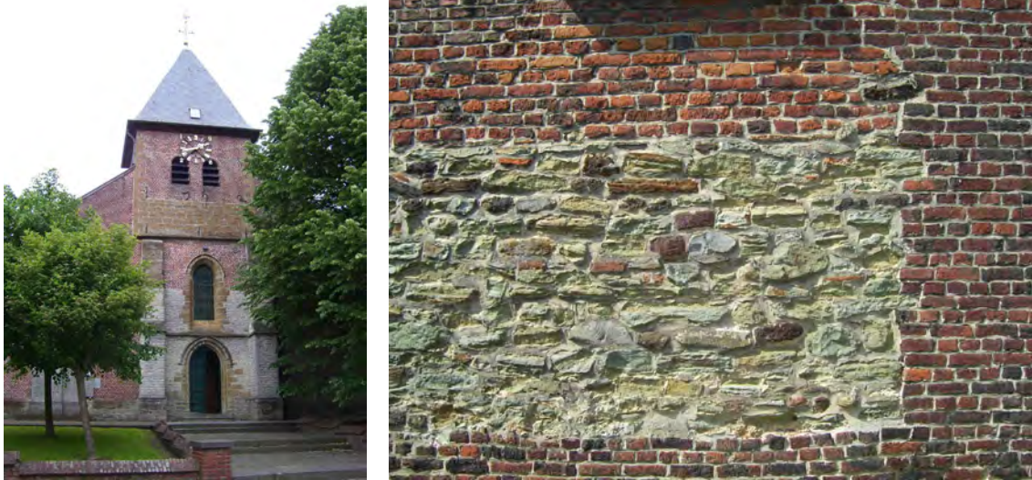
Figuur 10. Gebruik van natuursteen tussen baksteen in de Sint-Amanduskerk te Outer (Ninove) (links) en de Sint-Pieterskerk te Kerkem (Maarke-Kerkem) (rechts).
