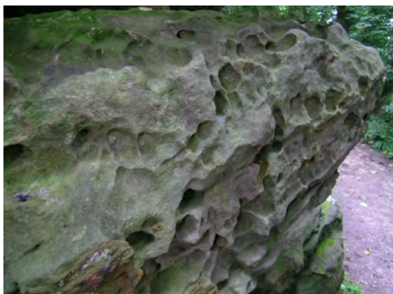
Figuur 11. Alveoli in Bentheimer zandsteen, stadspomp, Brielle (nov. 2008).
