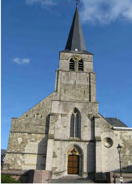
Foto 1 - Ledesteen vervangen door Franse witte steen in de Sint-Martinuskerk te Oordegem
