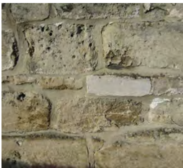
Foto 3 en 4 - Vervanging van de Ledesteen in de Sint-Annakerk te Bottelare door Euville (links) en Savonnière (rechts)
