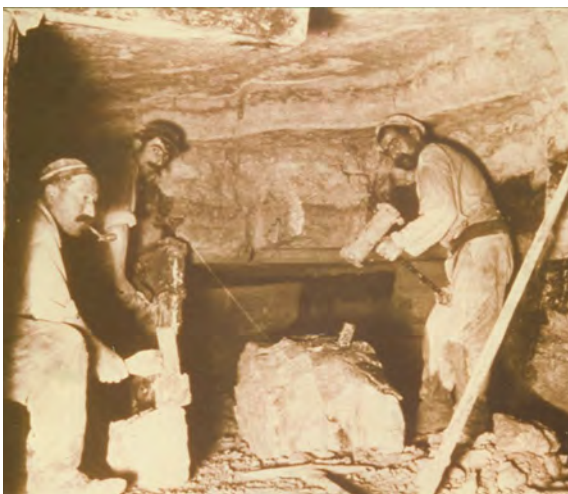
Figuur 11. Blokbrekers in een krijtsteengroeve in Noord-Frankrijk, vermoedelijk rond 1900. Foto uit Bivert 1988.
