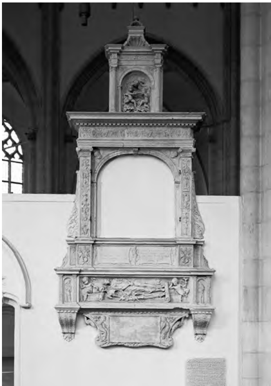
Figuur 21. Arnhem, Eusebiuskerk. Epitaaf van Joost van Sasbout van omstreeks 1550. Avendersteen, onderdelen vervangen in Baumberger steen. Foto Hendrik Tolboom.
