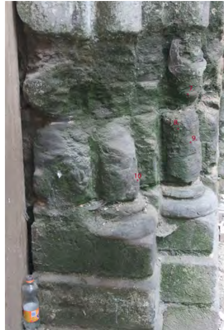
Figuur 9. Sterk verweerde Doornikse stenen zuilen. (Veurne, Sint-Niklaaskerk, vroeg-gotisch portaal)
