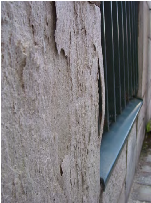
Figuur 3. Exfoliatie van micarijke zandsteen, Divaeus College, Leuven (nov. 2008).
