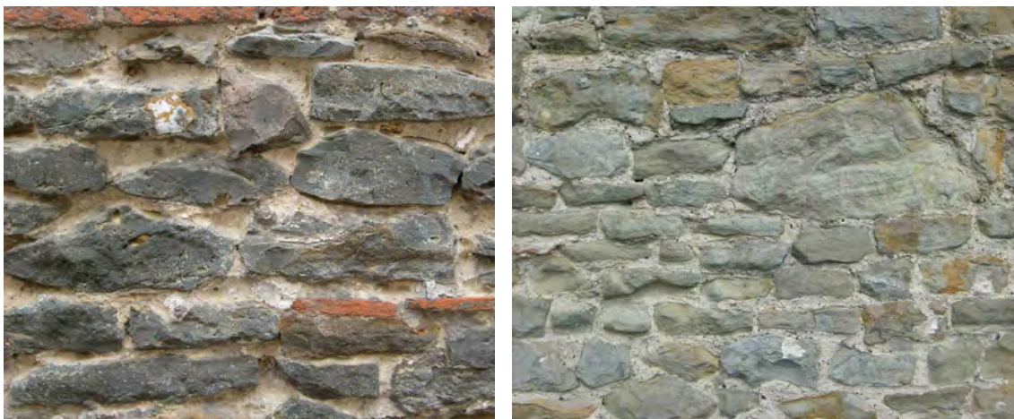
Figuur 13. Veldsteen in de muur van het Algemeen Stedelijk Ziekenhuis te Geraardsbergen en de Heilige Kruiskerkmuur te Lotenhulle (Aalter).
