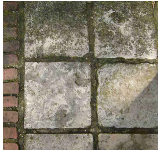
Figuur 15. Tegels in Gobertangesteent voor de Sint-Aldegondiskerk te Mespelare (Dendermonde)
