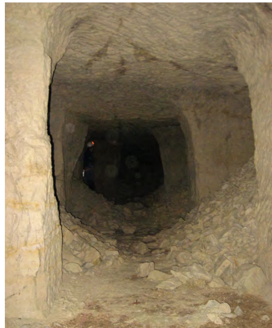
Figuur 9. Kamer en pijler afbouwmethode volgens regelmatig patroon met rechte gangen (vermoedelijk 18de – 19de eeuws). Dwarsgangen opgevuld met afvalmateriaal dat tot 80 volumepercent kon bedragen. Fosse Leroy te Avesnes-le-Sec. (Foto Michiel Dusar)
