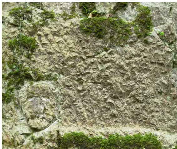
Figuur 12. Schuine lijnen veroorzaakt door het houweel (Fr.: escoude) tijdens het uithouwen van de kleine sleuven tussen de rotswand en de te ontginnen blokken in de gracht van de burcht Château-Thierry (Foto F. Doperé).
