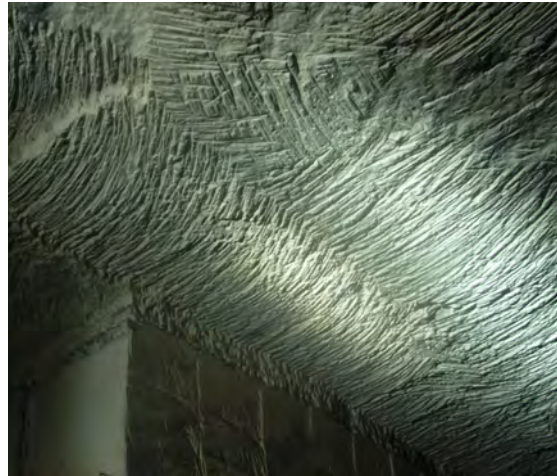
Figuur 14. Maastrichtersteen: groeve Lacroixberg te Zussen. Gebogen lijnen op het plafond van de voormalige ontginningsfronten, veroorzaakt door de hak, waarmee de te ontginnen blokken of sjtolen van het plafond werden losgehakt (Foto F. Doperé).
