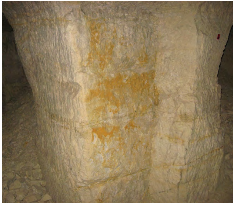
Figuur 10. Pijlerwand met haksporen en ingehakte grensvlakken tussen de blokken (parpaings). Fosse Leroy te Avesnes-le-Sec. (Foto Michiel Dusar)
