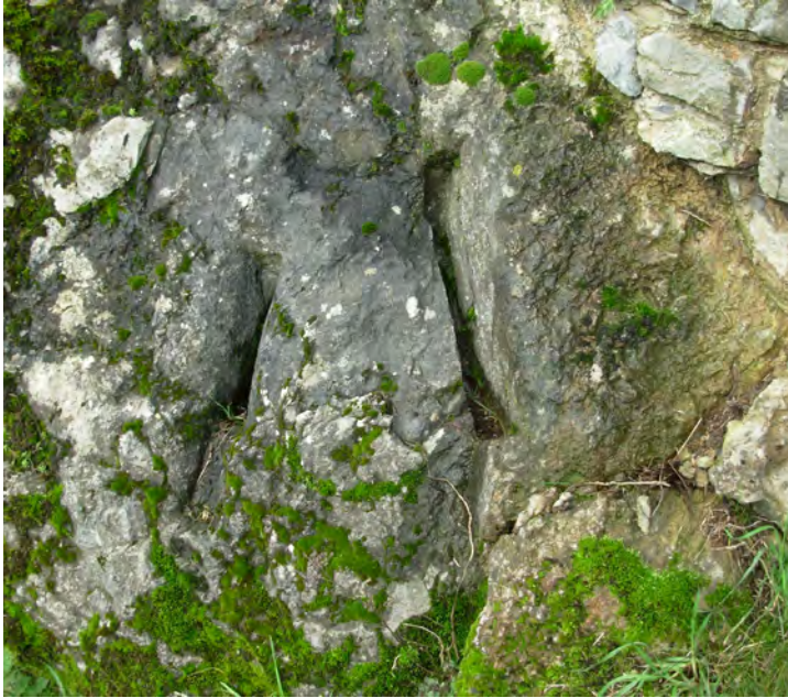
Figuur 8. Willekeurig in de rots gehouwen grote spiegaten in de kelder van de burcht van Logne (Foto F. Doperé).
