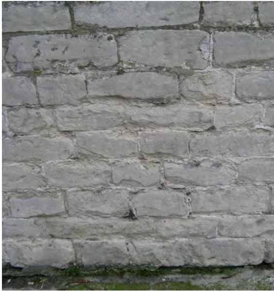
Figuur 14. Brusseliaanse steen in de Onze-Lieve-Vrouwekerkmuur te Rupelmonde (Kruibeke)
