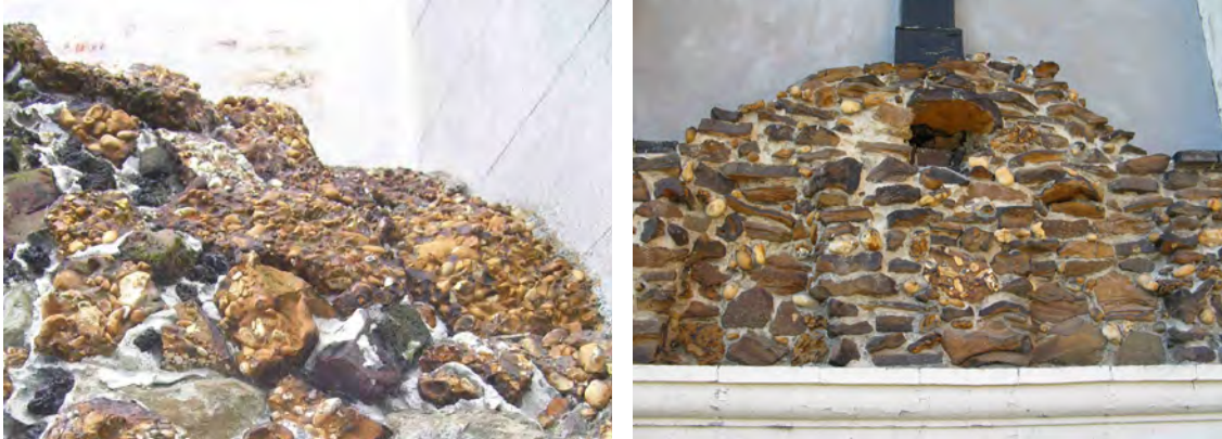
Figuur 12. “Puddingsteen” aan de kerk te Zarlardinghe (Geraardsbergen) en de kerk te Nukerke (Maarkedal), muur in ijzerzandsteen te Maarke (Maarke-Kerkem).
