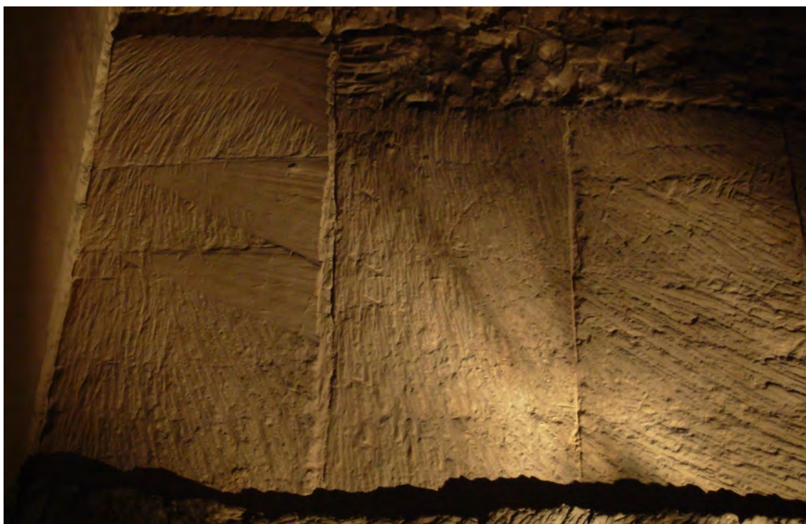
Figuur 15. Maastrichtersteen: groeve Lacroixberg te Zussen. Driehoekige patronen veroorzaakt door het afwisselend gebruik van de zaag en de hak bij het aanbrengen van de verticale sleuven naast de sjtolen (Foto F. Doperé).
