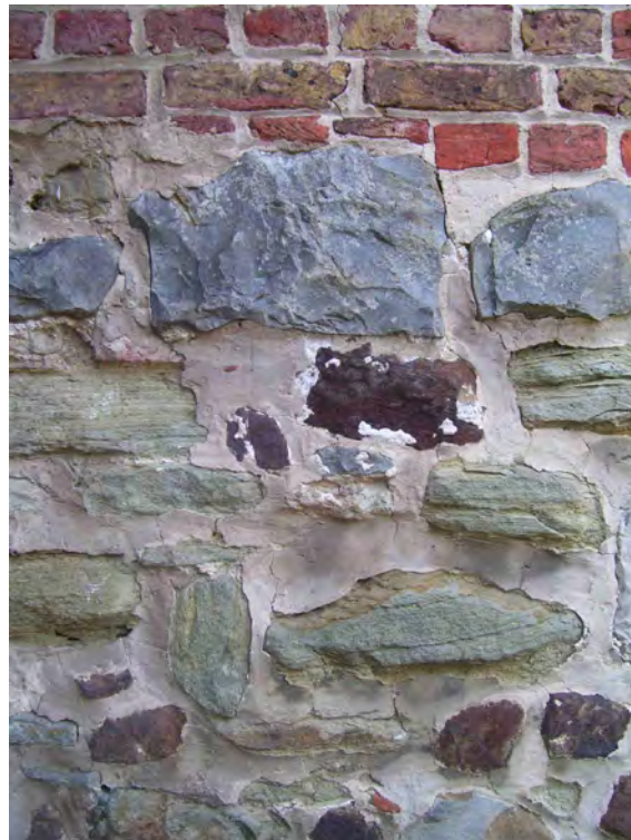
Figuur 2. Veldsteen in de Sint-Pieterskerk te Kerkem (Maarke-Kerkem) – combinatie van de 'groene' (centraal en onder) met de 'blauwe' variant (bovenaen)
