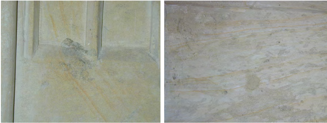
Figuur 20. Kenmerkend voor de Avendersteen zijn de graafgangen opgevuld met grijsgroene glauconietkorrels. Monument van Engelbrecht van Nassau in de Grote Kerk te Breda. Foto Hendrik Tolboom.
