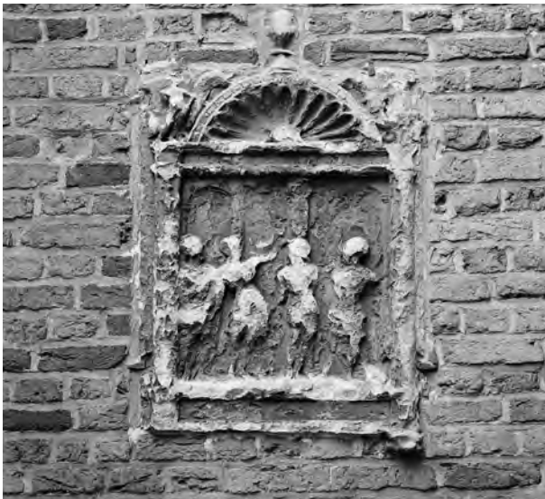
Figuur 22. Vught, NK kerk. Deze passievoorstelling van Avendersteen uit het begin van de 16e eeuw is recentelijk geheel doordrenkt met metamethylacrylaat (Jbach-methode) om verder verval te stoppen. Foto RACM.
