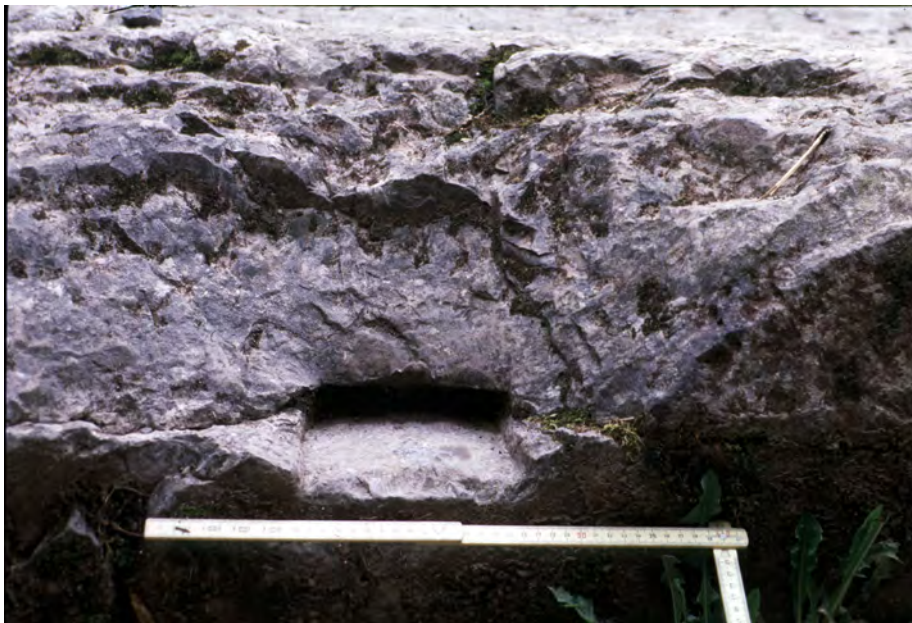
Figuur 5. Horizontaal uitgehouwen spiegelat in de gracht van de burcht van Logne (Foto F. Doperé).
