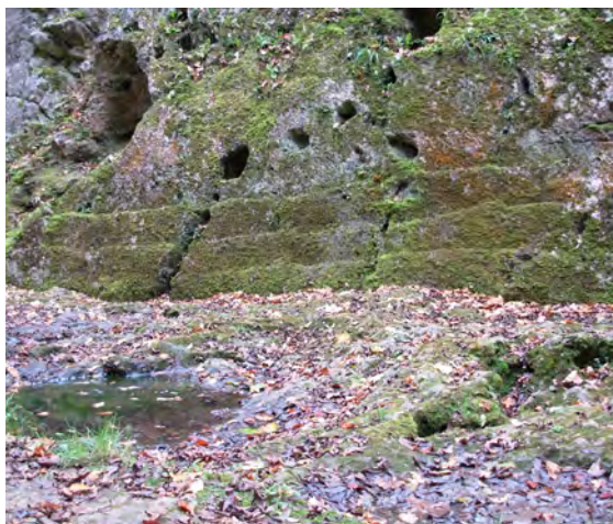
Figuur 11. Sporen van de opeenvolgende ontgonnen steenbanken in de gracht van de burcht Château-Thierry (Foto F. Doperé).
