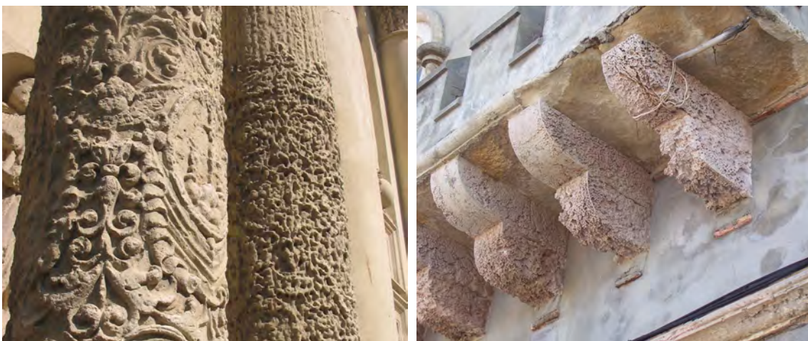
Figuur 10. Alveoli in kalksteen in Lecce (jul. 2005), rechts aan het Castelo Engenheira Silva, Figueira do Foz (sept. 2007).
