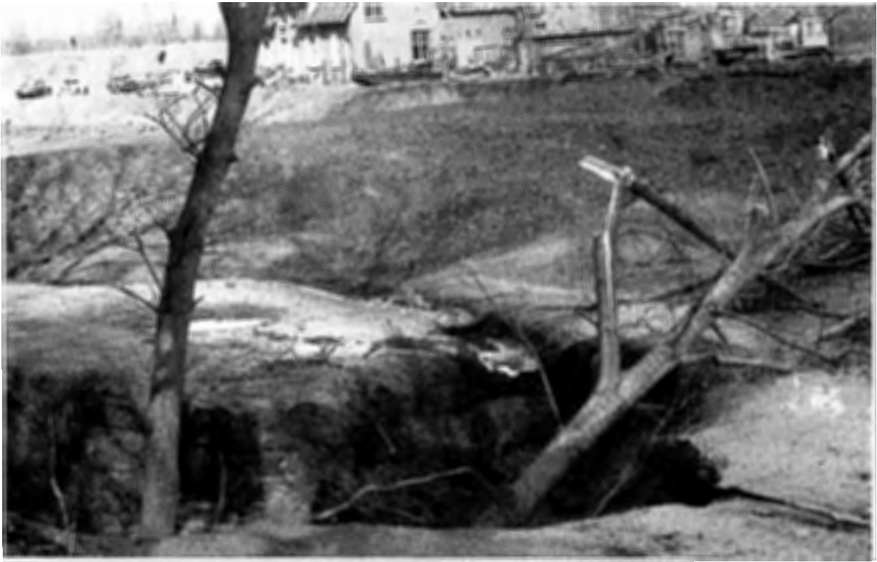
Fig. 5 - Effondrements M, M', M''
