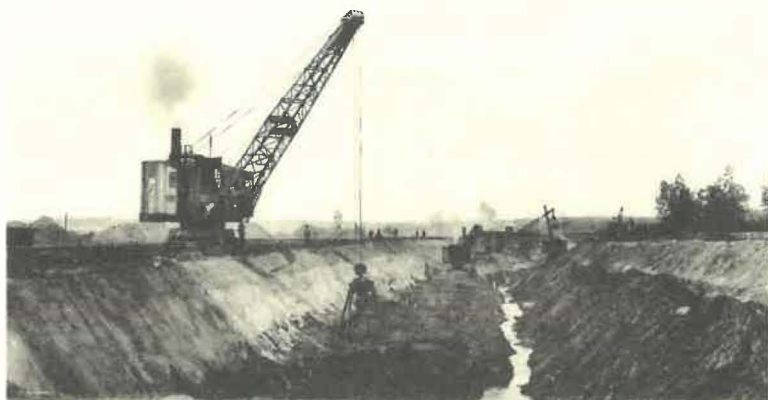
3. - Chantier des "Charbonnages de Bonne Fin", en 1943. (Cliché Delens).
