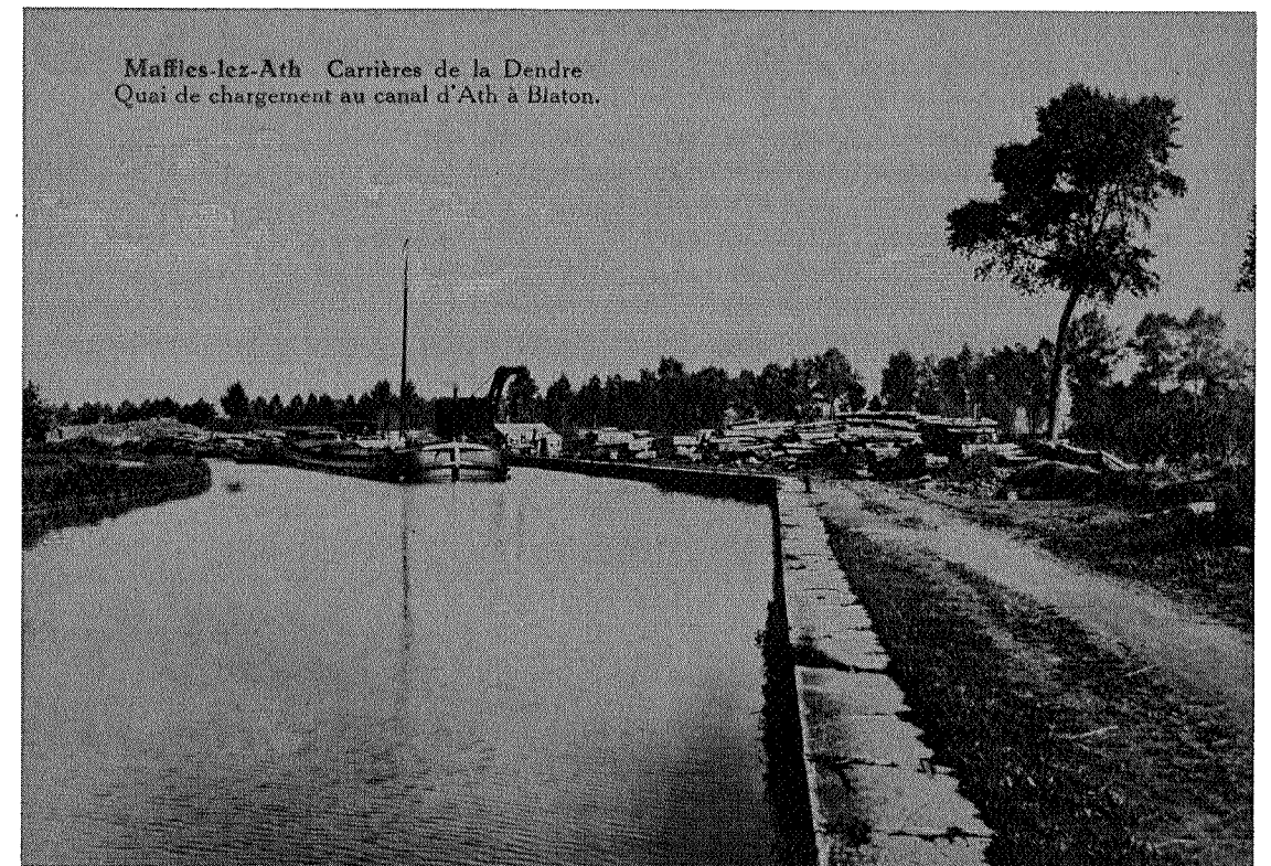
Figure 9. Chargement des pierres de la carrière de la Dendre au canal d'Ath à Blaton vers 1936 (Carte postale Ars Nova, collection du musée de la pierre).
