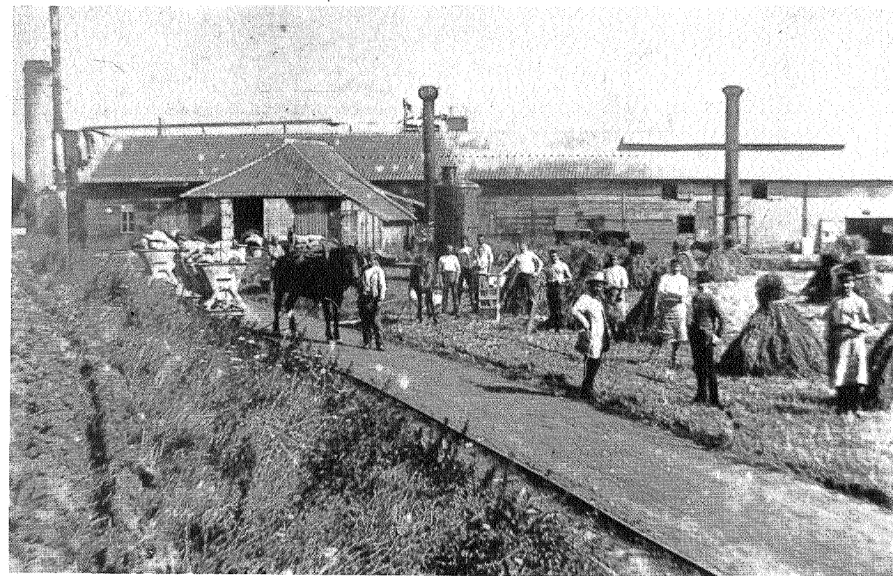
Figure 3. Cuesmes. Usine de la Malogne. Le traitement des craies exploitées est réalisé sur place : il s'agit uniquement de la séparation des grains phosphatés et du carbonate de calcium.
