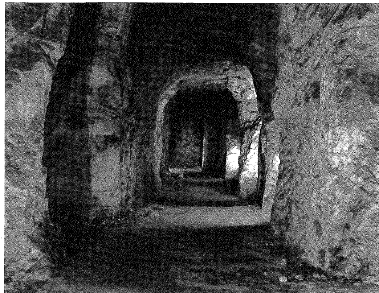
Figure 4. Cuesmes. Carrière souterraine de la Malogne. Vue typique d'une exploitation souterraine par chambres et piliers abandonnés (photo Leclercq & Wuilbaut).
