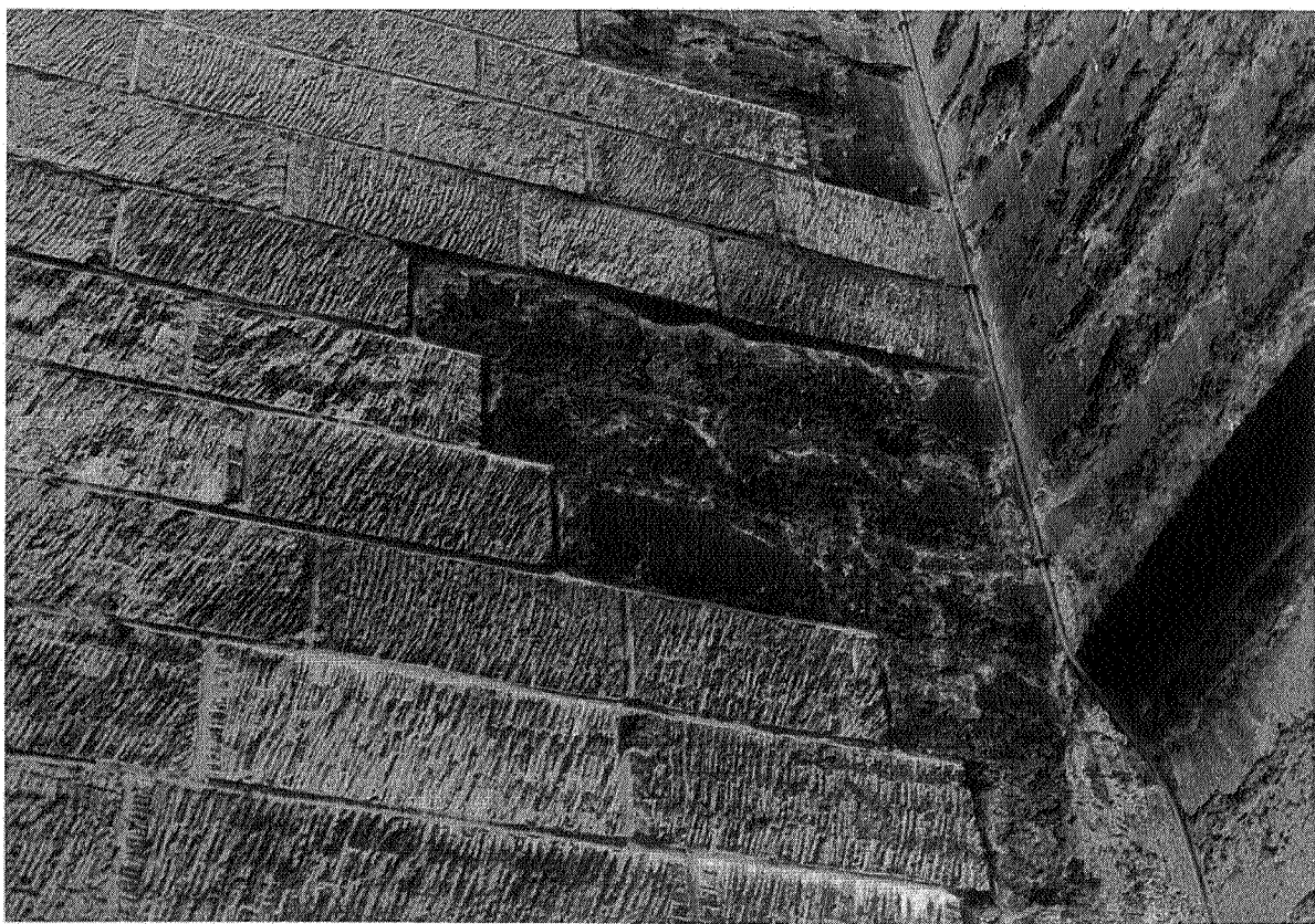
Figuur 1 : Brussel, St. Michielskathedraal : versnelde afbraak van het oorspronkelijk materiaal door vervangingen met nieuwe steen.
