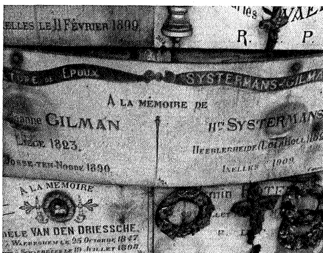
FIG. 12. — Fléchissement dans le sens horizontal d'une plaque de marbre dans la crypte du cimetière de Saint-Josse.
