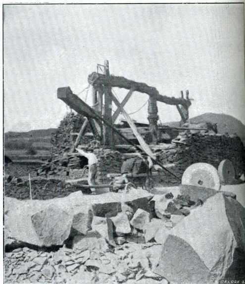
EXTRACTION DU BASALTE PAR Puits A NIEDERMENDIG.
