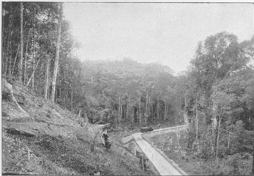
FIG. 3. — GUYANE. — LE CHEMIN DE FER DE SAINT-LAURENT AU MARONI UNE COURBE DE 50 MÈTRES DE RAYON
