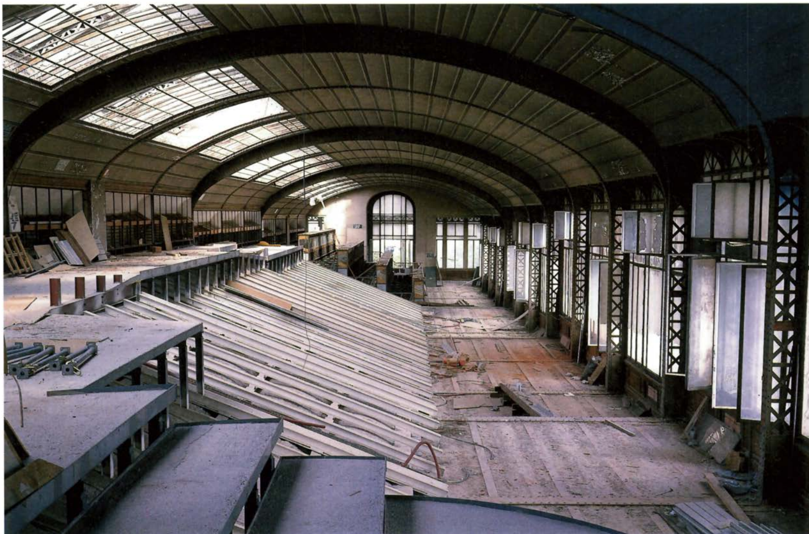
De bovenverdieping van de Janletvleugel
