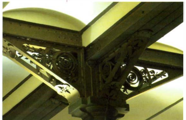
De gietijzeren zuilen en de ijzeren balken van de zoldering zijn door smeedijzeren consoles aan elkaar geklonken.
