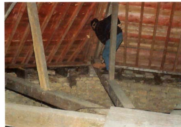
© Nettoyage de la passerelle et des entrants des combles d'une église. (J. Fairon, CRC-I.R.Sc.N.B.)
