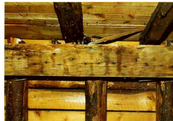
© Une observation attentive est souvent nécessaire: ici, des oreilles dressées sur la panne faîtière trahissent la présence d'un oreillard.(J. Fairon, CRC-I.R.Sc.N.B.)
