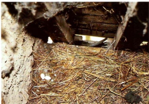
© Un nid de martinet noir situé sur le mur porteur, sous le bord inférieur d'une toiture. (J. Fairon, CRC-I.R.Sc.N.B.)
