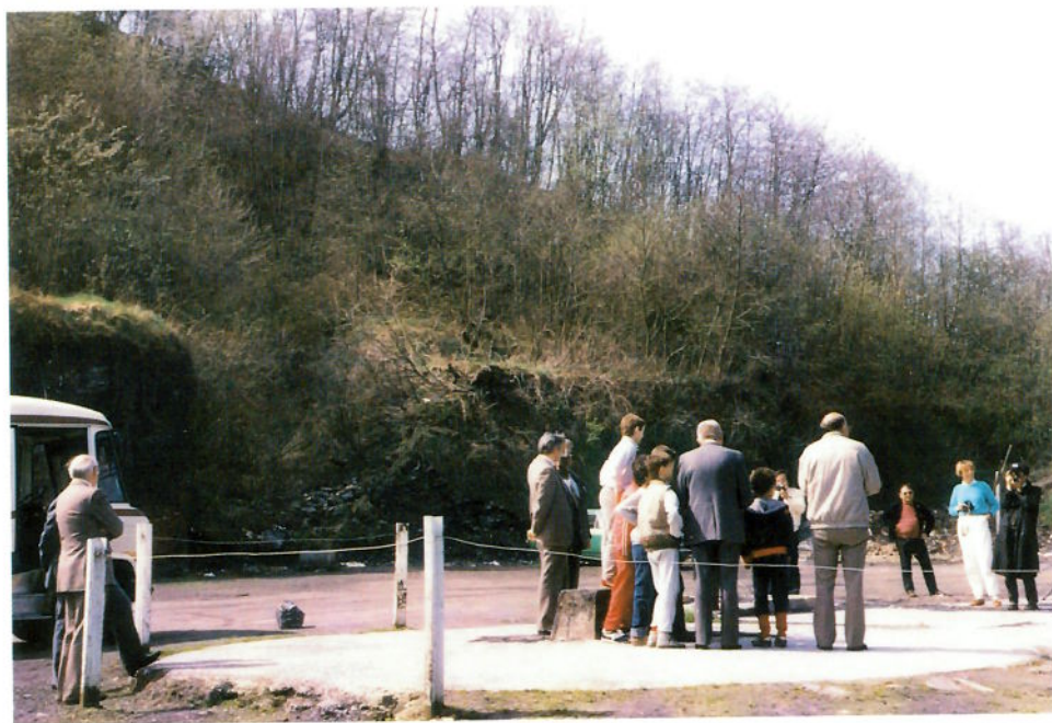
Figure 5. — L'accès à la Fosse Sainte-Barbe a été récemment scellé avec une dalle de béton.
