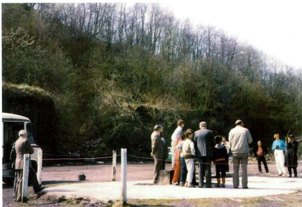
Figuur 5. — De Sint-Barbaraput werd recent afgesloten met een betonnen sluitsteen.
