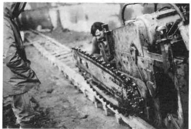
Fig. 16 et 17 — Premiers essais en carrières de la chaîne à molettes expérimentale
