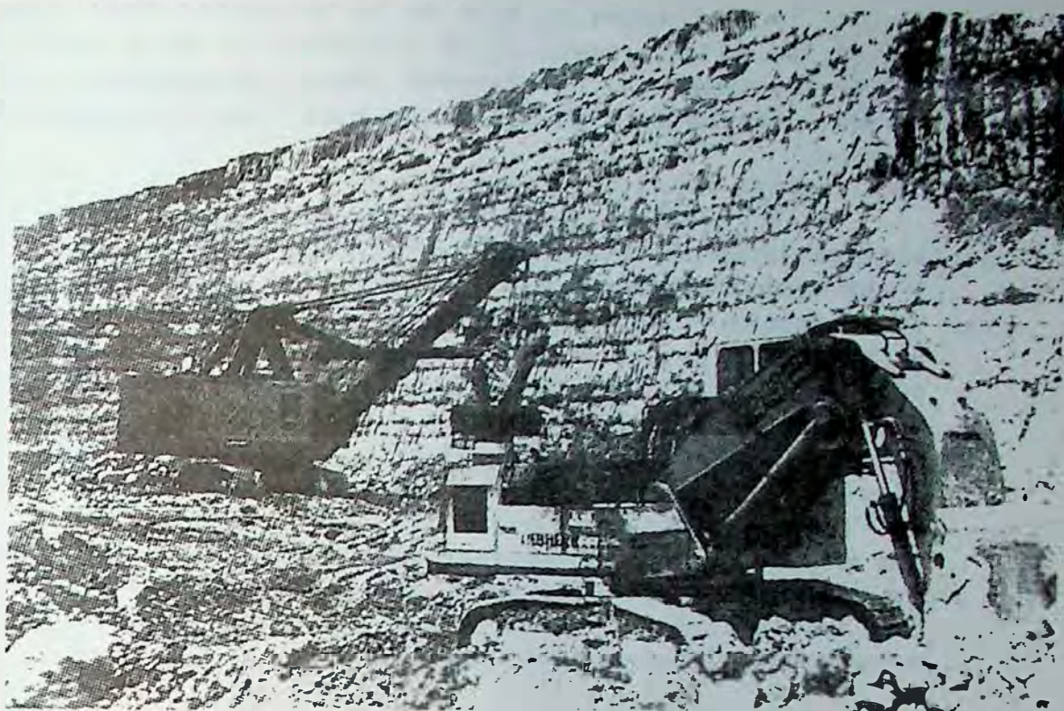
Photo n° 6. Exploitation en roche tendre. Extraction et chargement par pelle hydraulique ou électrique.
