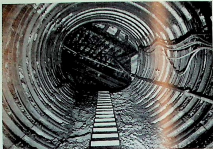
Fig. 6 : Escalier en béton dans une galerie pentée
