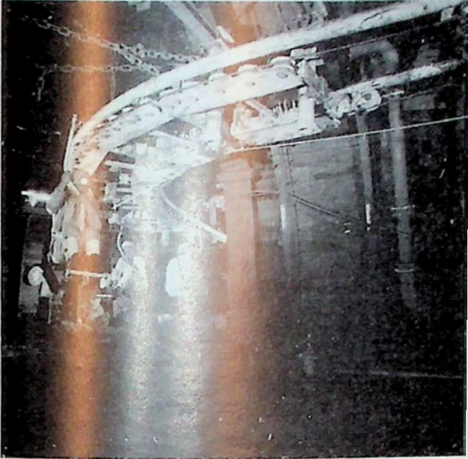
Fig. 15 : Installation d'un télésiège AP0D dans les courbes
