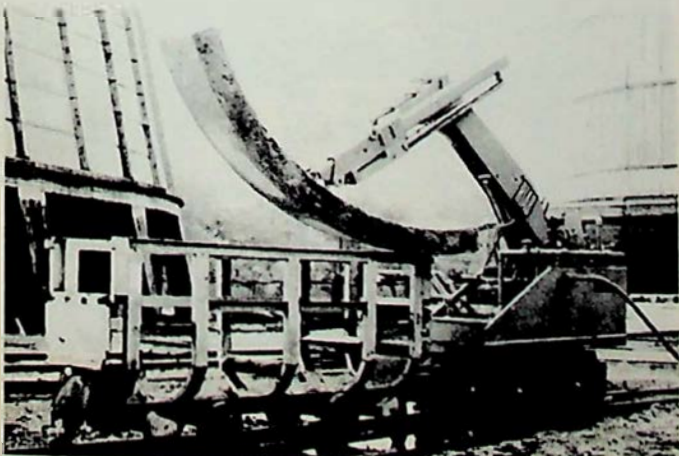
Fig. 4 : Machine de pose sortant un panneau de la berline spéciale utilisée pour son transport dans le fond
