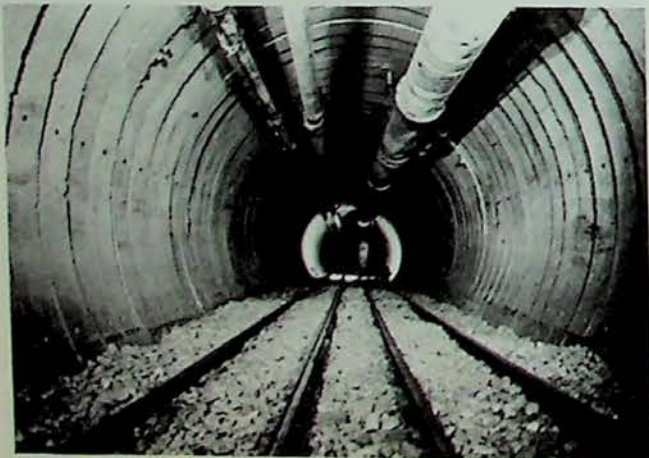
Fig. 7 : Premier nouveau revêtu de panneaux en béton armé, réalisé en 1967 au siège de Beringen
