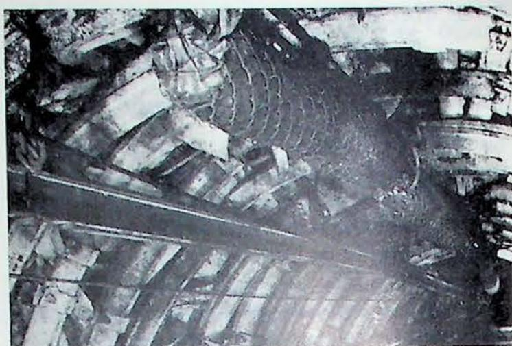
Fig. 33 — Premiers éléments de la ligne d'extincteurs après un an de séjour au fond (charbonnage d'Eisden).
