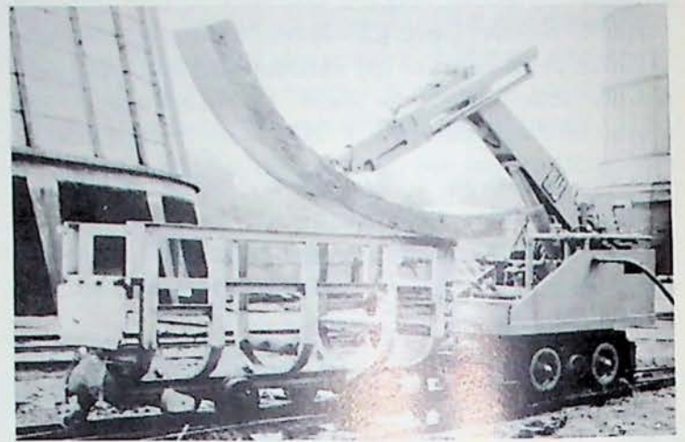
Fig. 9. — Le panneau amené de la surface dans un truck est saisi par la machine de pose (machine à 360° sur le siège de Zolder). Het paneel aangevoerd van de bovenzijde in een truck wordt door de plaatsingsmachine vastgegrepen (machine gebouwd op de afdeling Zolder).
