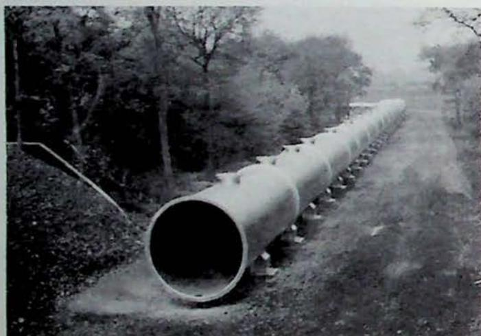
Fig. 12 — Conduite de 2500 mm  $\phi$ .
