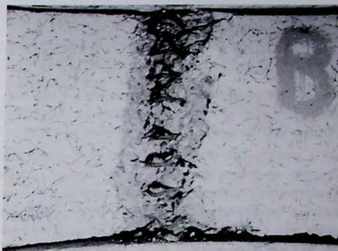
Fig. 1 — Foto van de breukzone van de ring uit panelen van beton die gebast is bij de zeer hoge belasting van 540 t; men kan de doorknikking zien van de 8 langsstaven aan de binnenkant. Van de twee kanten van de breuk kan men de Bekaert-metaaldraden zien van 0,5 mm diameter en 60 mm lengte die verzonken zijn in het beton.
