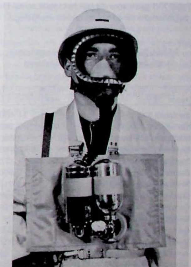
Fig. 31 — Autonoom toestel met gesloten kring Fenzy 66
