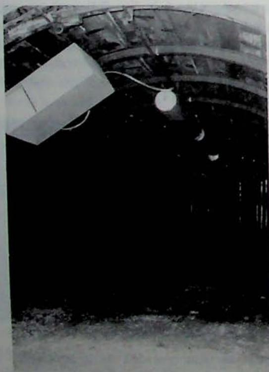
Fig. 23 — Disposition en galerie d'un détecteur connecté à une file d'éléments extincteurs
