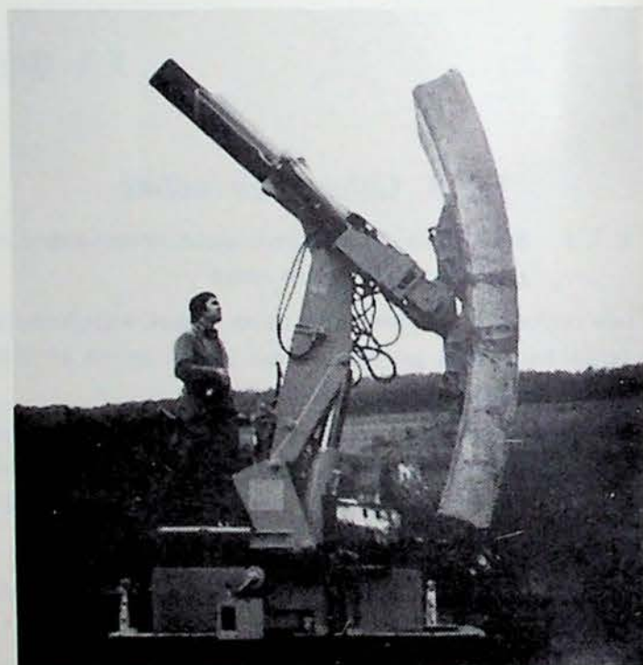
Fig. 1 : Machine de pose des panneaux en béton armé utilisés comme revêtement de tunnels de chemins de fer en France. La manutention des panneaux s'effectue par des ventouses travaillant sous vide.
