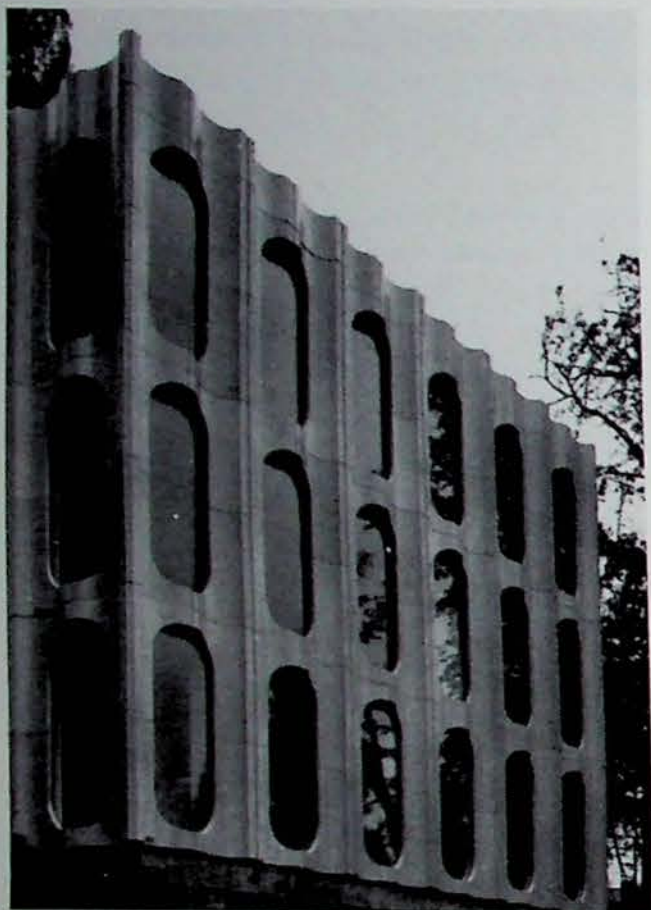
Fig. 9 : Façade en éléments obtenus par moulage à partir d'un mélange de fines calcaires et de résine polyester
