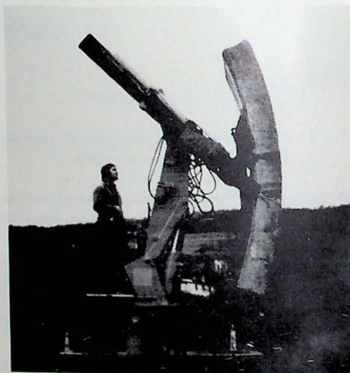
Fig. 1. — Plaatsingsmachine voor panelen van gewapend beton die gebruikt worden als bekleding voor spoorwegtunnels in Frankrijk. Het verplaatsen van de panelen gebeurt door vacuümwerkende zuignappen.
