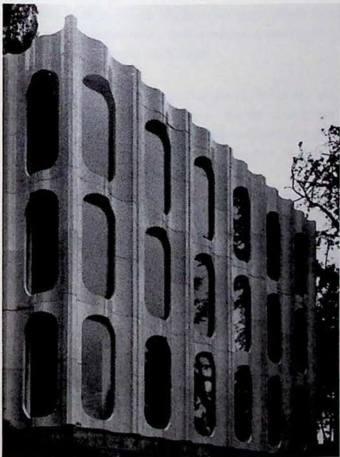
Fig. 2 — Façade en éléments obtenus par moulage à partir d'un mélange de fines calcaires et de résine polyester Gevel in elementen verkregen door vorming uitgaande van een mengsel fijne kalksteen en polyesterhars
