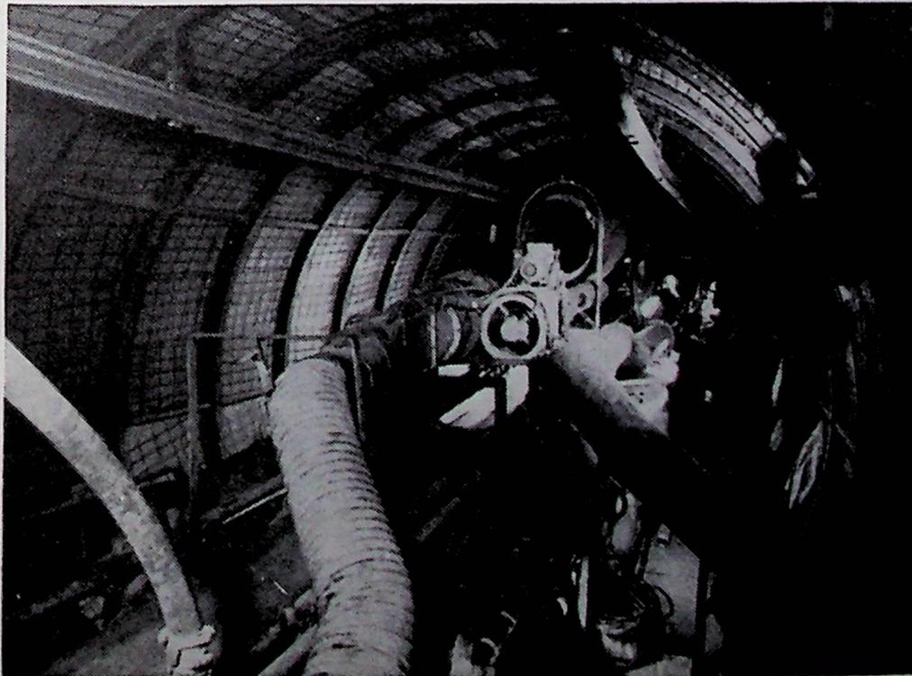
Fig. 5 : Machine frigorifique de 4000 kcal/h pour le poste de commande
