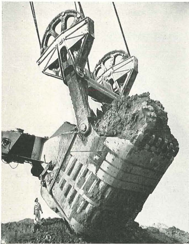
Fig. 9. Le godet de la pelle. De eigenlijke schop.
