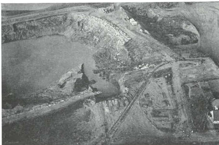
Fig. 4. — Point d'irruption des eaux, après obturation.
