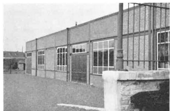
Fig. 26. Atelier de mécanique-menuiserie-magasin. Werkhuis mechanica-schrijnwerkerij-magazijn.
