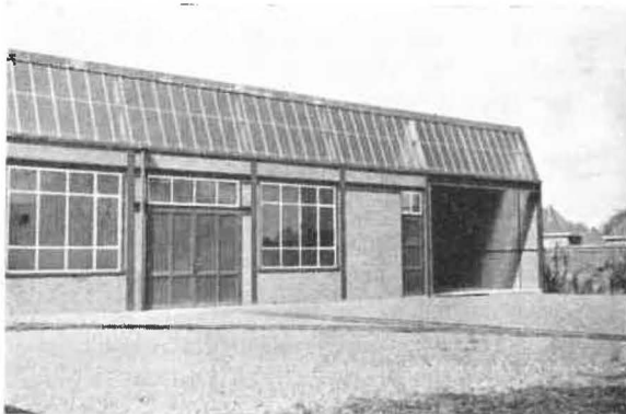
Fig. 25. Atelier d'électricité. Werkhuis elektriciteit.
