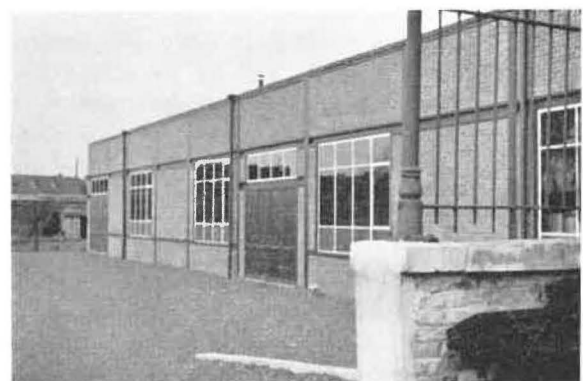
Fig. 26. Atelier de mécanique-menuiserie-magasin. Werkhuis mechanica-schrijnwerkerij-magazijn.
