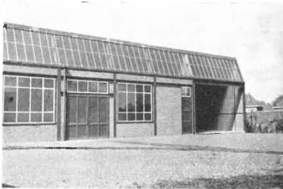
Fig. 25. Atelier d'électricité. Werkhuis elektriciteit.
