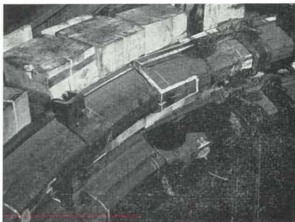
Fig. 74. — Photo montrant la déchirure à l'intrados d'un élément de cadre qui a eu pour conséquence de faciliter le chevauchement d'un élément de cadre sur l'autre.
