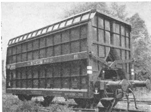
Fig. 33. — Wagons-trémies à déchargement automatique.
