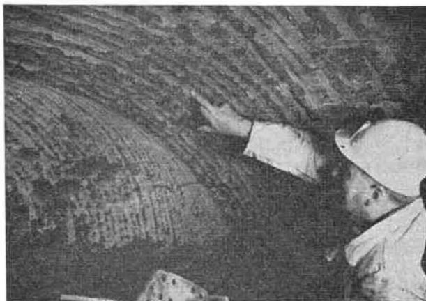
Fig. 10. — Trajectoire (25 mm de largeur) des outils de coupe des fraises extérieures.
