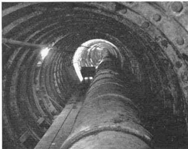
Fig. 34. — Galerie sous une rivière avec revêtement en acier coulé.
