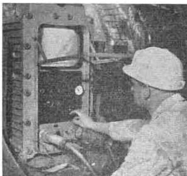
Fig. 1. — Equipement réception TV — antigrisouteux — pour examen des trous de sonde de faible diamètre.
