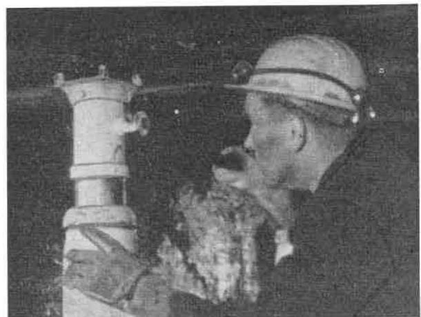
Fig. 8. — **Opération H** — Placement d'un étau hydraulique, en taille.
