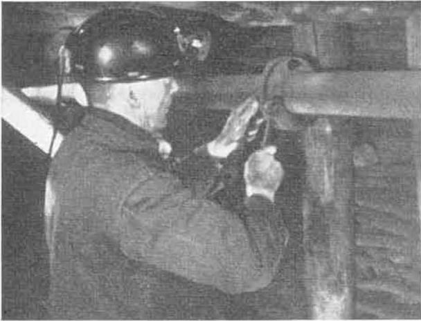
Fig. 3. — **Opération C** — Raccordement de tuyauteries.
