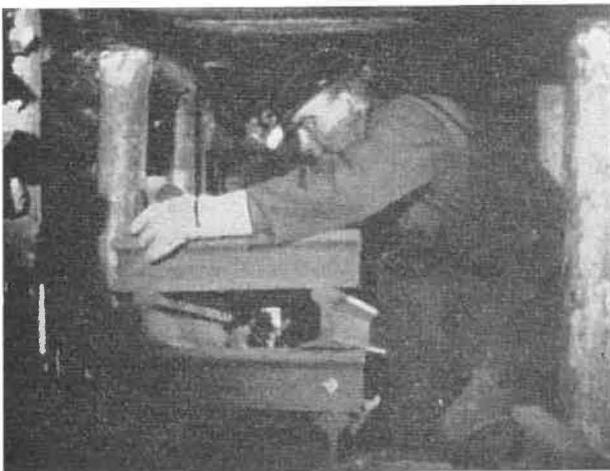
Fig. 5. — **Opération E** — Erection d'une pile de rails, en taille.
