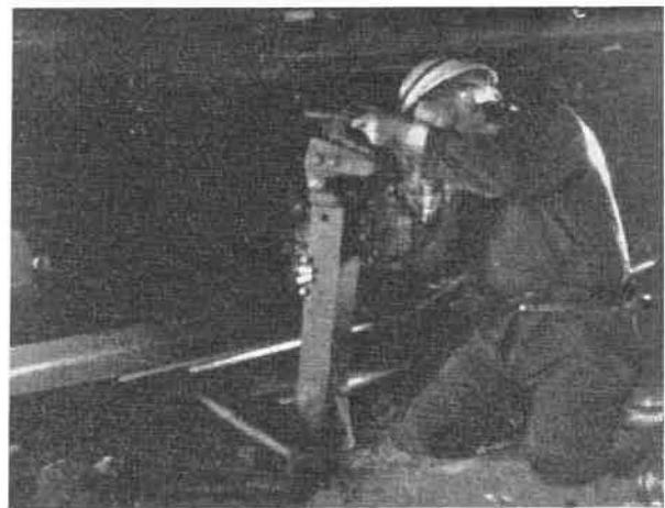
Fig. 7. — **Opération G** — Placement d'un étau à friction, en taille.
