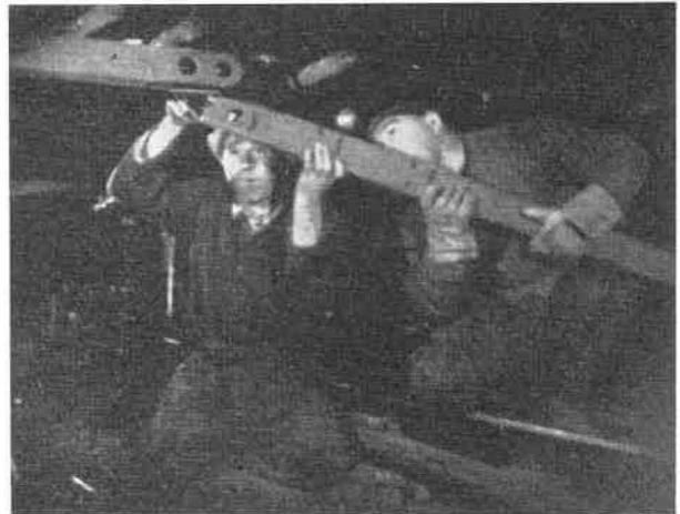
Fig. 6. — **Opération F** — Placement d'une bèle métallique, en taille.
