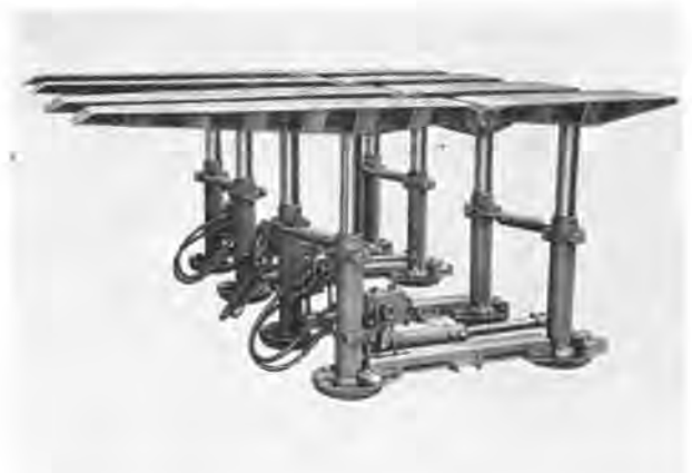
Fig. 15. — Élément 800/1300 muni de tringles de stabilisation pour couches pentées.
