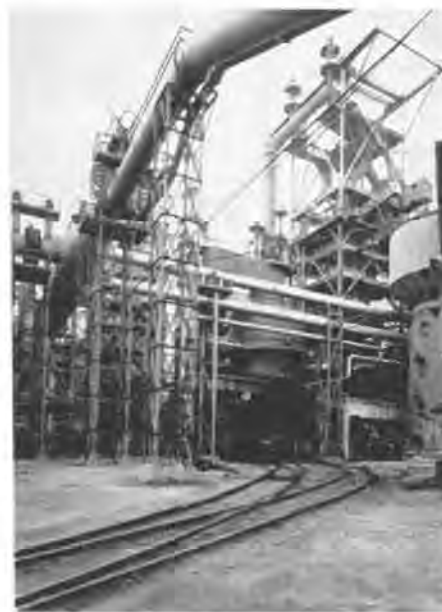
S.A. Usines Gustave Boël. — Haut fourneau. S.A. Usines Gustave Boël. — Hoogoven.
