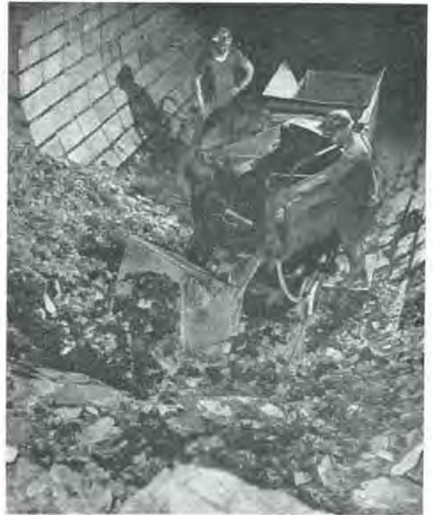
N.V. Kolenmijnen Limburg-Maas. — Creusement de bouveau - Chargeuse mécanique.
