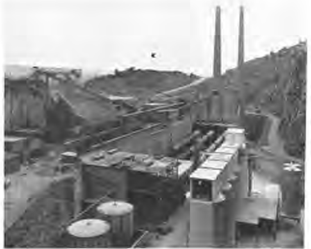
S.A. des Carrières et Fours à Chaux Dumont-Wautier - Siège de St-Georges-sur-Meuse. — Fours à chaux rotatifs. S.A. des Carrières et Fours à Chaux Dumont-Wautier - Zetel van St-Georges-sur-Meuse. — Rotatieve kalkovens.
