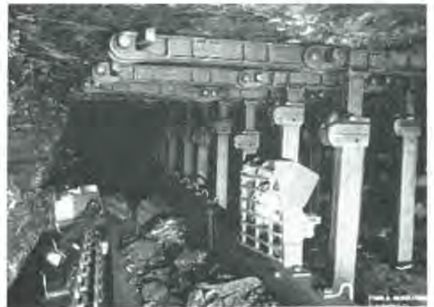
S.A. Charbonnages d'Hensies-Pommerœul. — Abatage mécanique en taille - Rabot rapide.
