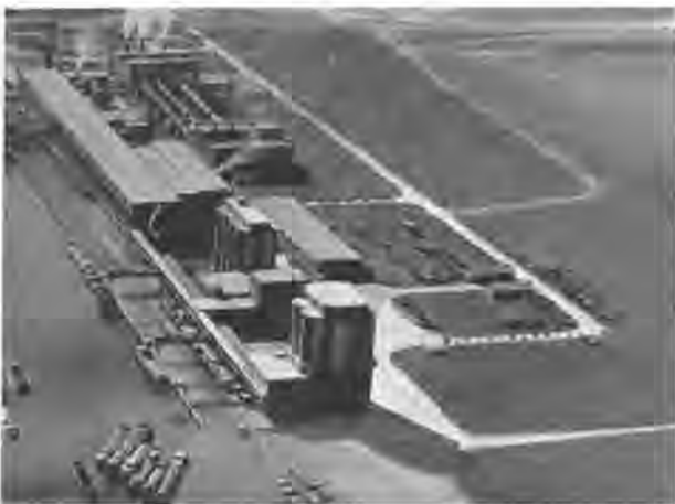
S.A. Cimenteries et Briqueteries Réunies. — Vue générale de l'usine de Lixhe.
