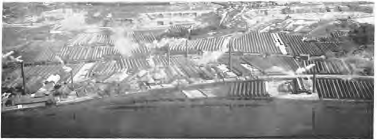
Briqueteries de la région du Rupel. — Vue aérienne d'une partie de la région du Rupel (Photo Lamarque). Baksteennijverheid der Rupelstreek. — Luchtfoto van een gedeelte der Rupelstreek (Foto Lamarque).
