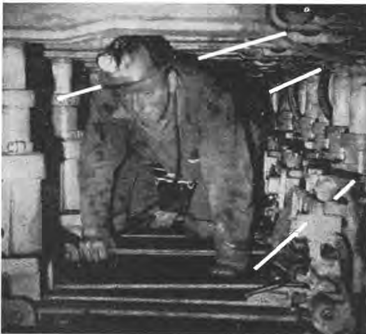
PILÉS HYDRAULIQUES DE SOUTÈNEMENT MARCHANT
