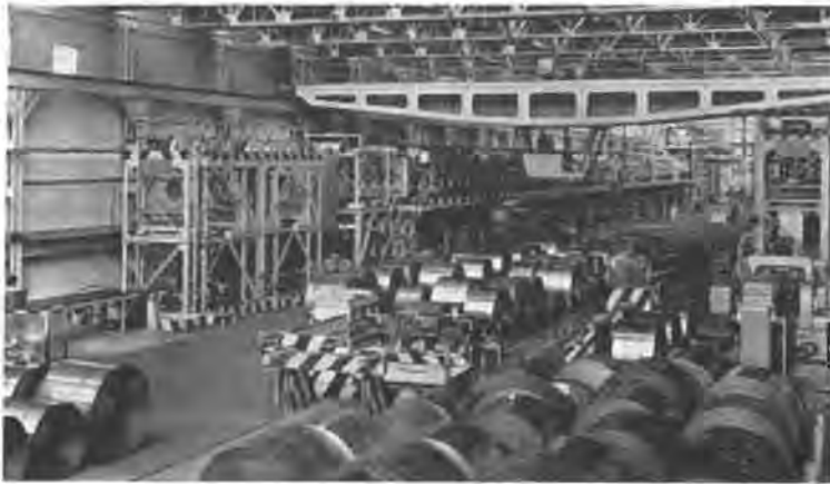
S.A. Phénix Works. — Ligne de galvanisation continue. S.A. Phénix Works. — Doorlopende galvanisatiewals.
