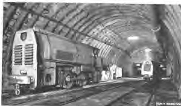
S.A. Charbonnages d'Hensies-Pommerœul. — Garage de locomotives Diesel.
