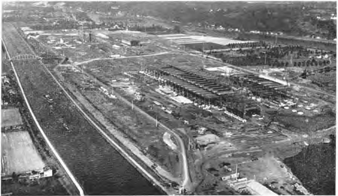
S.A. Métallurgique d'Espérance-Longdoz. — Vue aérienne de la nouvelle usine de Chertal en construction. S.A. Métallurgique d'Espérance-Longdoz. — Luchtfoto van de in opbouw zijnde fabriek te Chertal.
