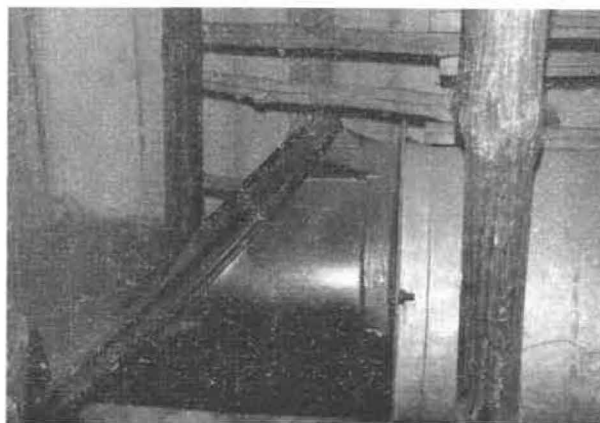
Fig. 3. — Veiligheidssluitklep in gesloten positie. Clapet de sécurité en position fermée.
