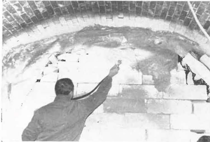
Fig. 4. Collage de toile de jute à la jonction du barrage, avec le toit de la galerie. Vasthechting van jute-doek tegen de voeg tussen afdamming en dak van de galerij.
