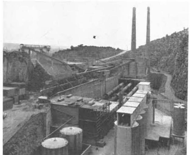
S.A. des Carrières et Fours à Chaux Dumont-Wautier - Siège de St-Georges-sur-Meuse. — Fours à chaux rotatifs.
