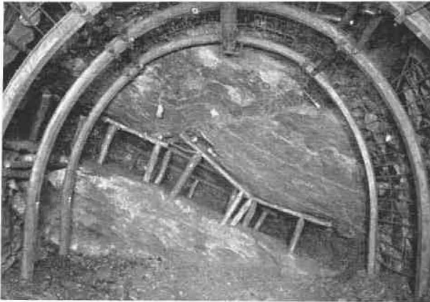
Fig. 17. — Siège n° 23. — Voie de base « débloquée » par scraper-houe. Toit lamellaire (dérangement).
