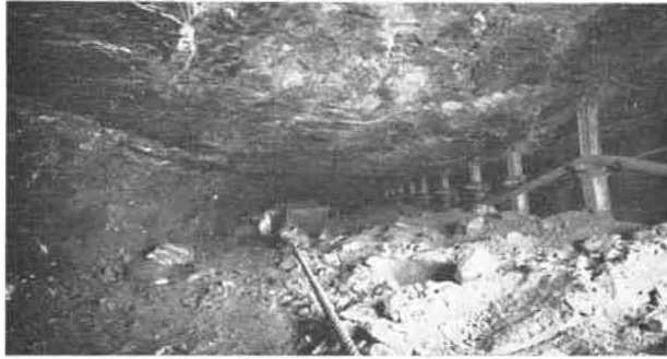
Fig. 14. — Siège n° 23. — Taille 4 Paumes levant à 1.220 m. Vue du scraper-bélier montrant également le soutènement par « étaçons à bêlettes », ainsi que la texture écaillée du toit.
