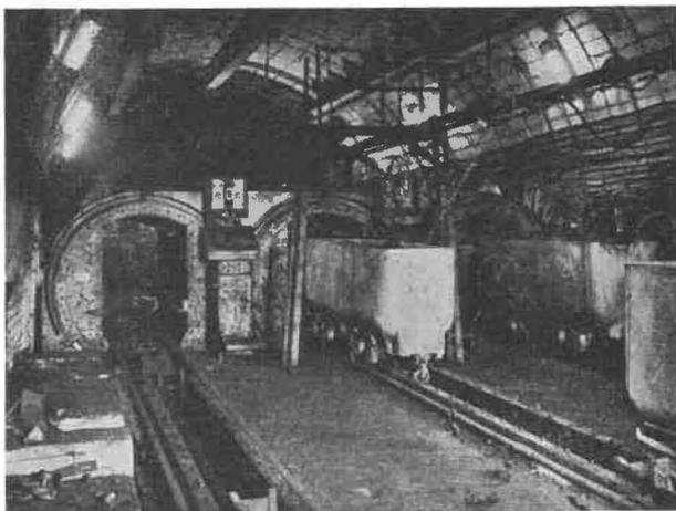
Fig. 2. — Recette d'alimentation des skips de la mine de Helchteren-Zolder, batterie de trois culbuteurs.
