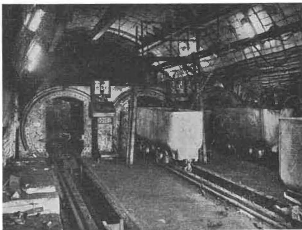
Fig. 2. — Recette d'alimentation des skips de la mine de Helchteren-Zolder, batterie de trois culbuteurs.
