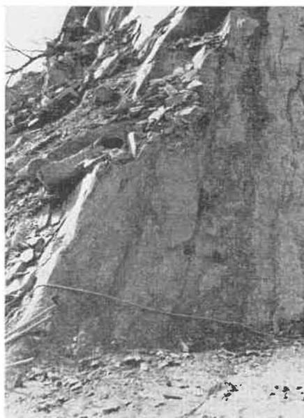
Fig. 1. — Coupe à travers-bancs montrant la succession des bancs de grès. On aperçoit au bas du rocher un fleuret de 3,20 m.
