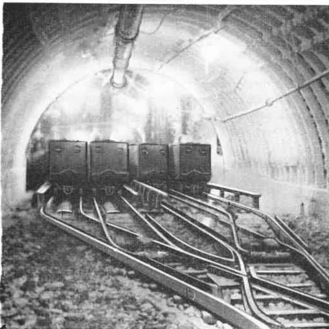
Fig. 7. — Installation de formation de train de berlines.
