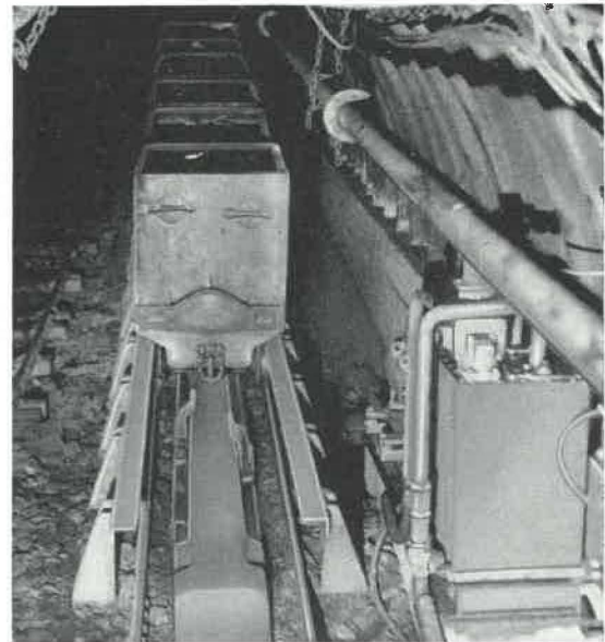
Fig. 6. — Ravanceur hydro-électrique, type RSH-25, monté sur plan incliné et remplaçant une releveuse de berline.
