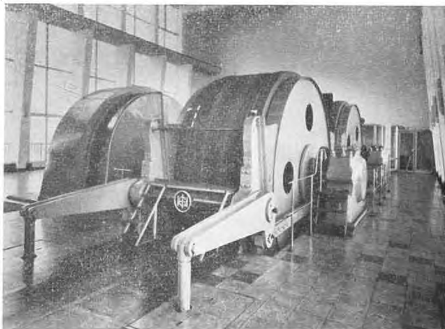
Machines d'extraction quadricâbles, charge utile 19,2 t, profondeur 1000 m, vitesse 16 m/sec, diamètre poulie Koepe 4,5 m
