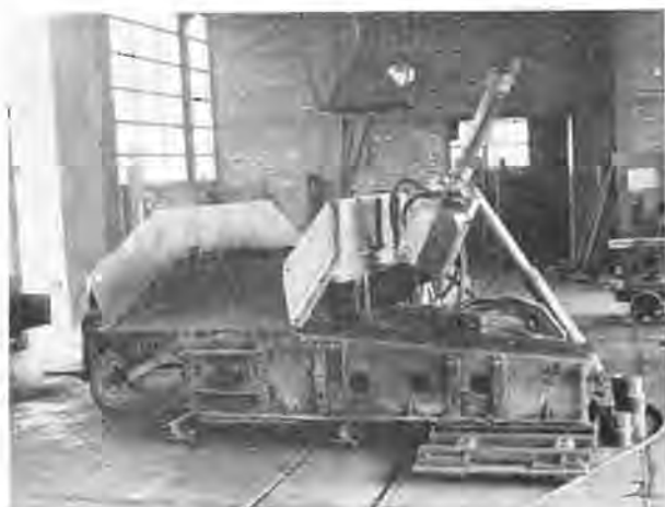
Fig. 40. — Photo de l'estacade, de l'infrastructure de la tête motrice et du pilot Flinois-Ogez.
