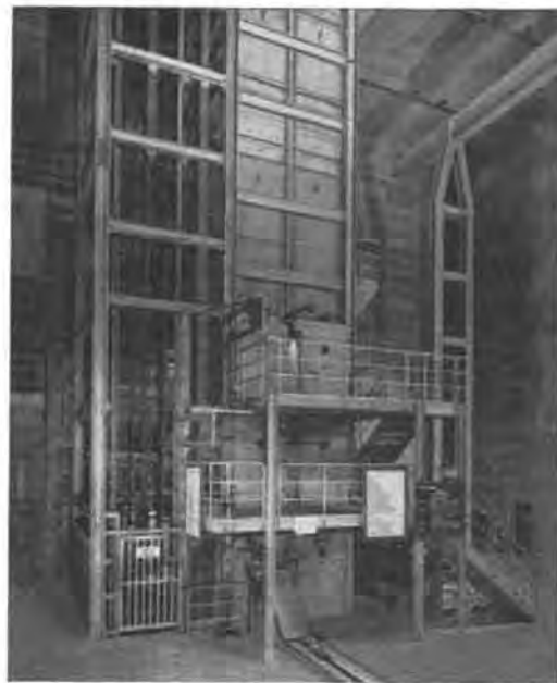
Sas à air à la surface, à commande électrique des portes dépression 400 mm CE.
