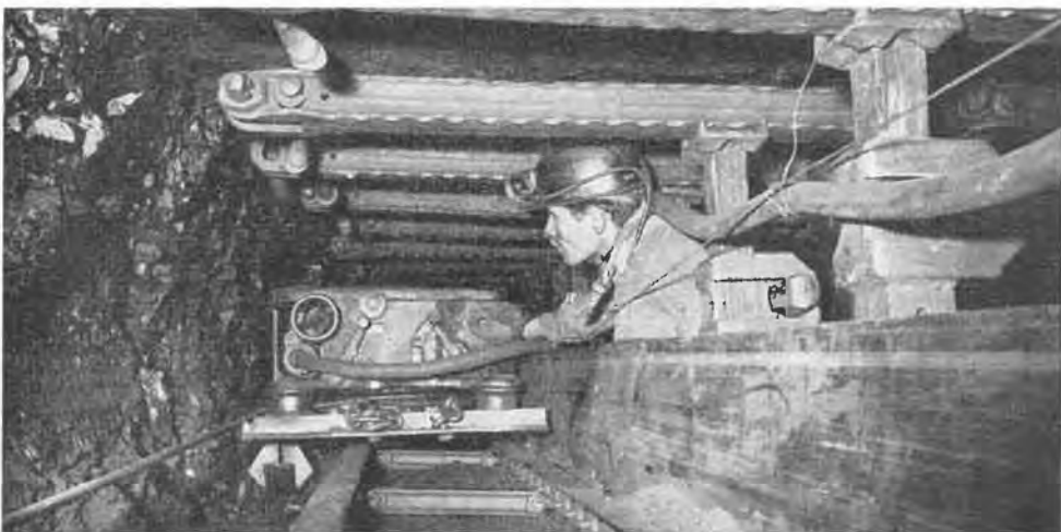
Fig. 5. — Vue de la partie supérieure de la haveuse avec le patin d'équilibre.
