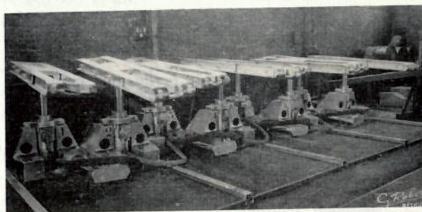
Fig. 20. — Soutènement Sahé-Somemi, type jumelé Sahé-Somemi, type Nord de la France.
