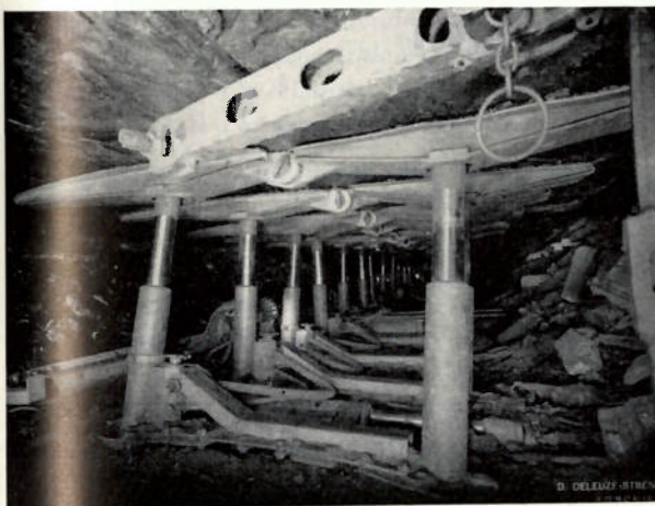
Fig. 16. — Soutènement Westfalia.
