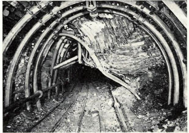
Fig. 35. — Brèche de recarrage dans la voie de base à 55 m du pied de taille. Tronçon en cadres Toussaint-Heintzmann posés sur claveaux lourds.
