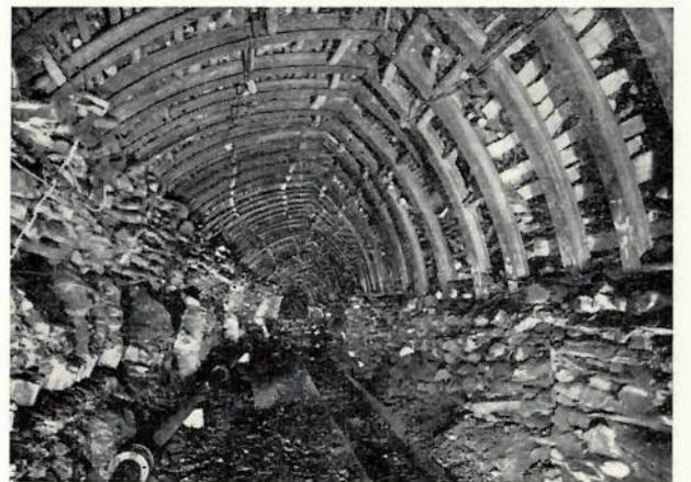
Fig. 37. — Tronçon en cadres articulés sur piles de bois photographié 7 mois après la pose. Les piles sont fort écrasées. La voie reste belle sans entretien.
