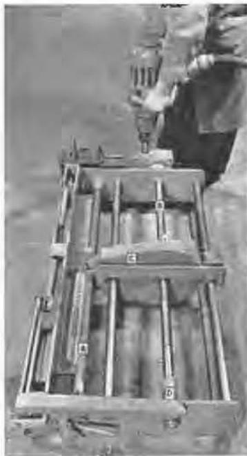
Fig. 7. — Agrafeuse mécanique — travail de confection du joint.
